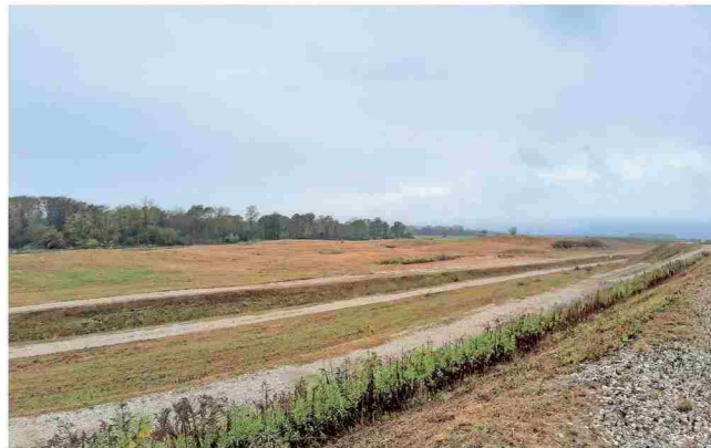
■ Deponija za sedimente iz akumulacijskega bazena. Dokler jih ne začnejo odlagati, bi lahko na njej stali sončni paneli.
