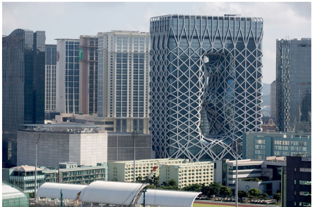
Hotel Morpheus v Macau na Kitajskem je prva zgradba na svetu, zgrajena s prostostoječim zunanjim jeklenim ogrodjem, prav tako delo biroja umrle iransko-britanske arhitektke Zahe Hadid. Foto: EPA
