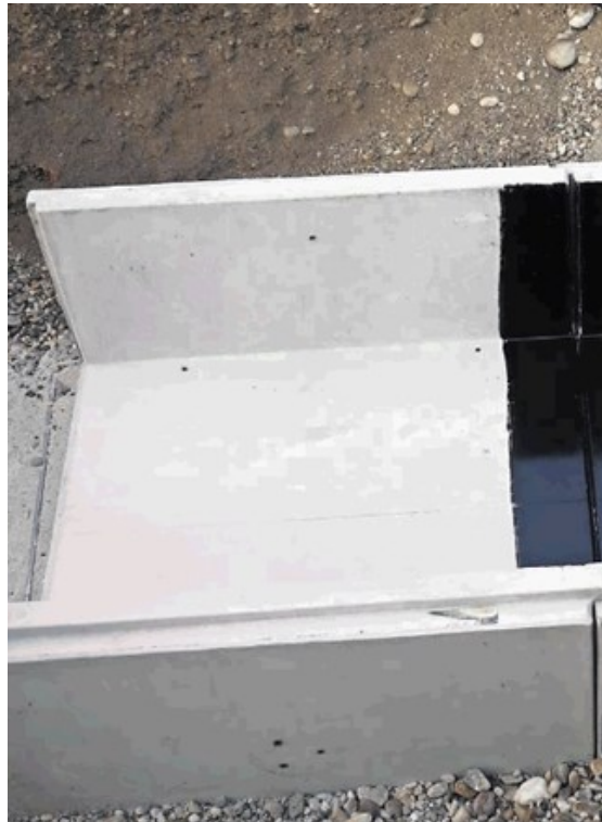
»Prebarvani« nevodotesni stiki betonskega »sarkofaga« brez vse
