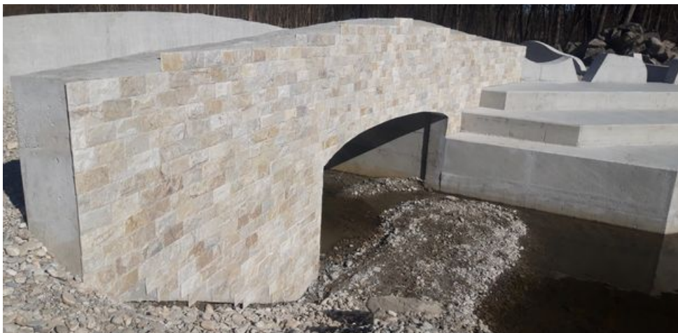
Most na Otok ljubezni je armirano-betonske nosilne konstrukcije, ki je obložena s kamnito oblogo. | FOTO: Občina Beltinci
