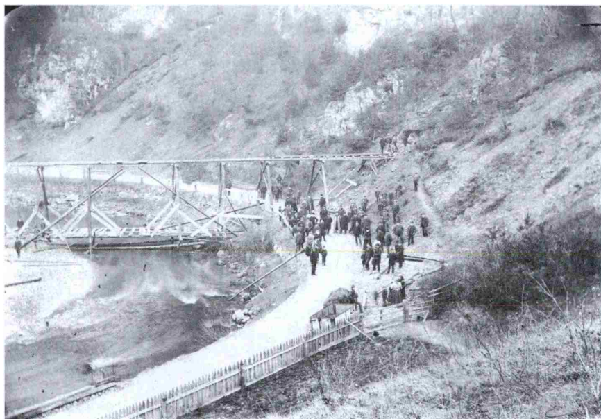
Gradnja železniškega tunela Skorno 1890 66
