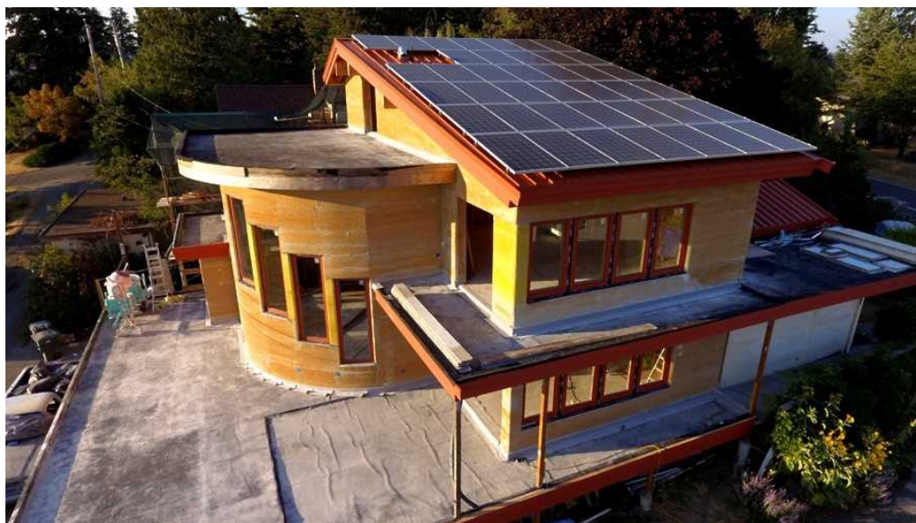
Gradnja hiše iz konopljenega betona v Bellinghamu, Washington, ZDA (foto Wikimedia)
