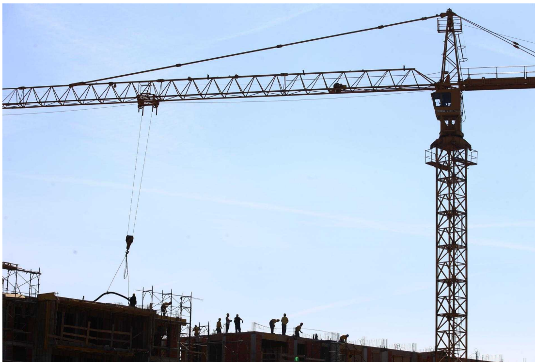
Vse od leta 2017 se zmanjšuje število izdanih gradbenih dovoljenj, kar za gradbeništvo dolgoročno ne pomeni nič dobrega. FOTO: Tadej Regent/Delo
