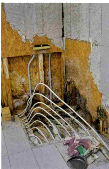
Poškodbe na stenah in nosilni konstrukciji v skeletni leseni hiši zaradi zastajanja tekoče vode. (foto: doc. dr. Boštjan Lesar)
