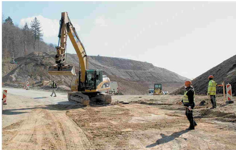
Na zahodni strani preboja so pretekli teden začeli graditi novo križišče. (Foto: R. N.)
