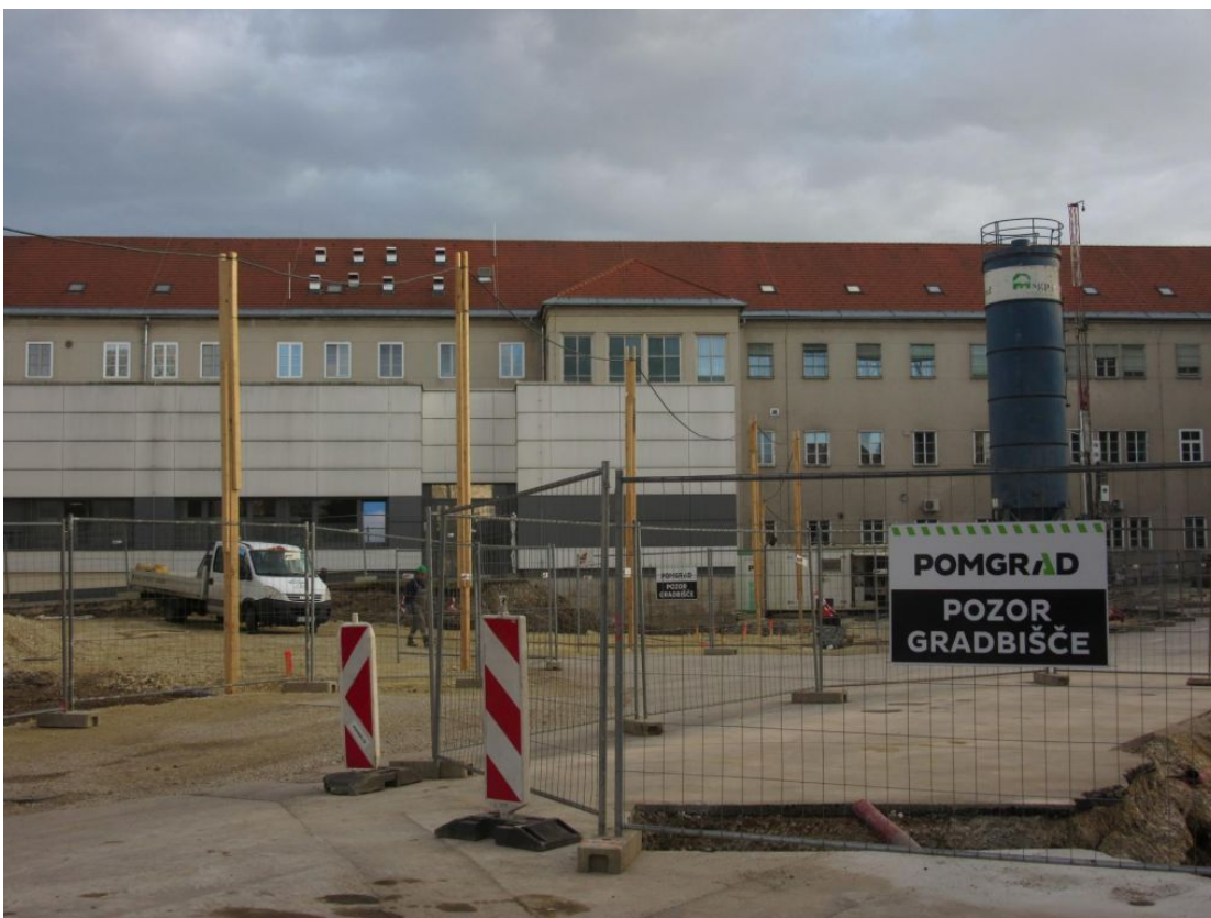
Gradbišče pri celjski bolnišnici ostaja odprto in deluje. FOTO: Špela Kuralt/Delo
