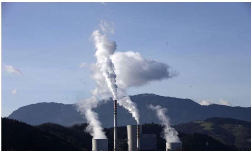
Termoelektrarna Šoštanj - Foto: Bobo
