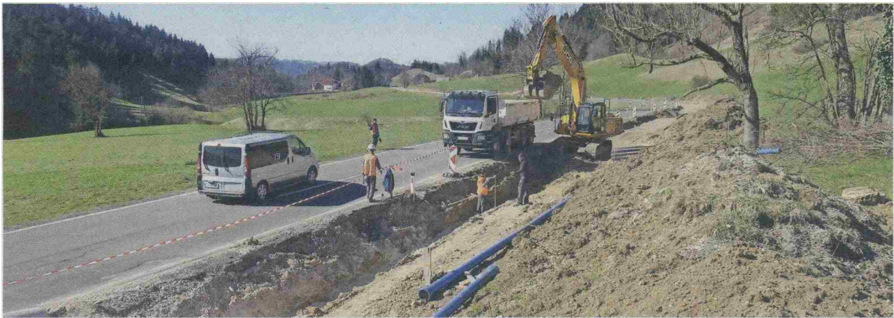
Na vseh živahnih gradbiščih (na fotografiji gradnja kanalizacije in vodovoda v Godoviču) v občini Idrija delavci nosijo gradbeno, ne pa tudi protivirusno zaščito.
