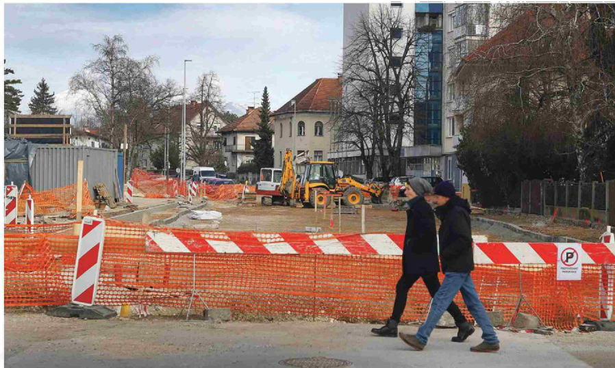
Dela na odseku med Smoletovo in Livarsko bodo končana konec meseca, marca se začnejo gradbeni posegi do Kurilniške. FOTOGRAFIJI LEON VIDIC
