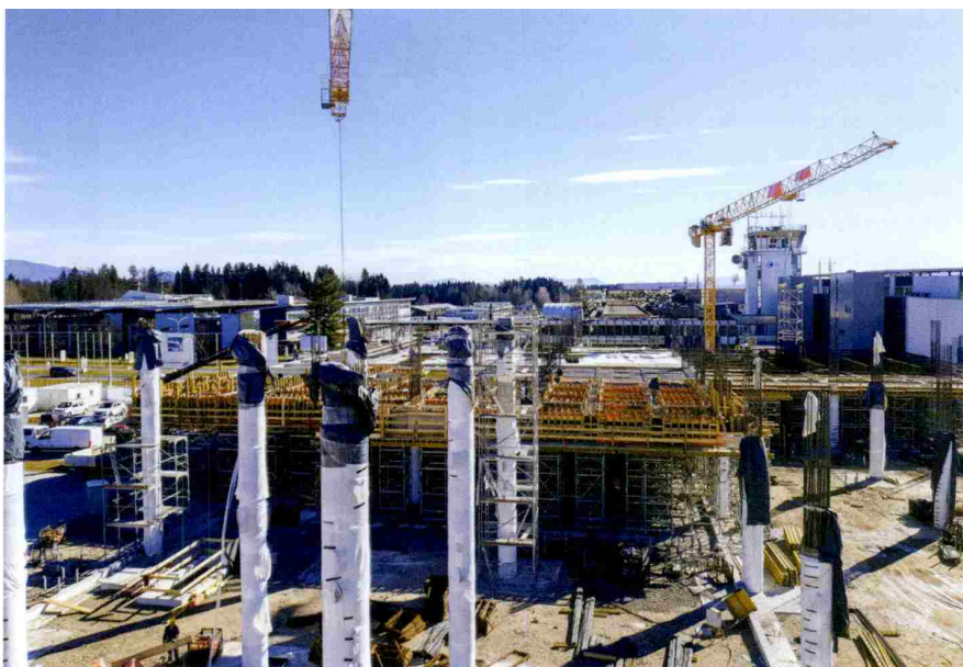
Izgradnja potniškega terminala na letališču Brnik
