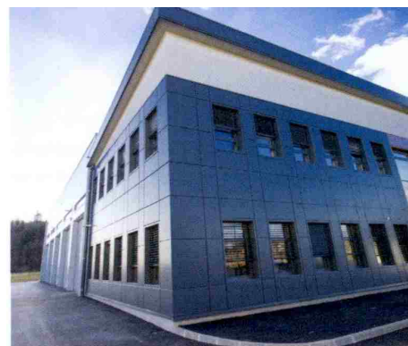
Razdelilna transformatorska postaja ELES Pekre
