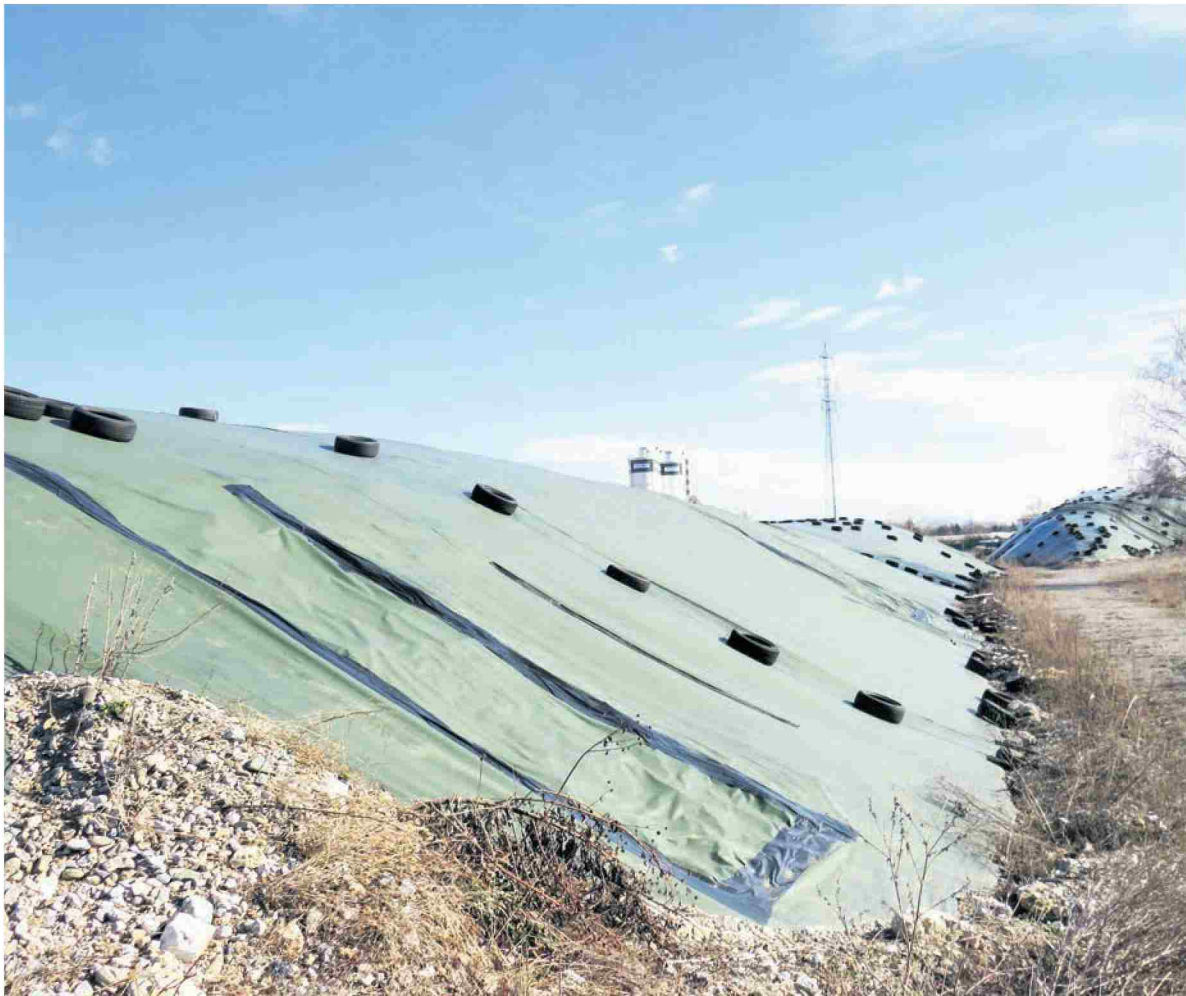
Kupi zemlje z nevarnimi odpadki ob železniški progi v Celju
