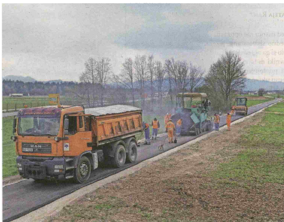
Asfaltiranje Beleharjeve ceste / Foto: arhiv Občine Šenčur,
