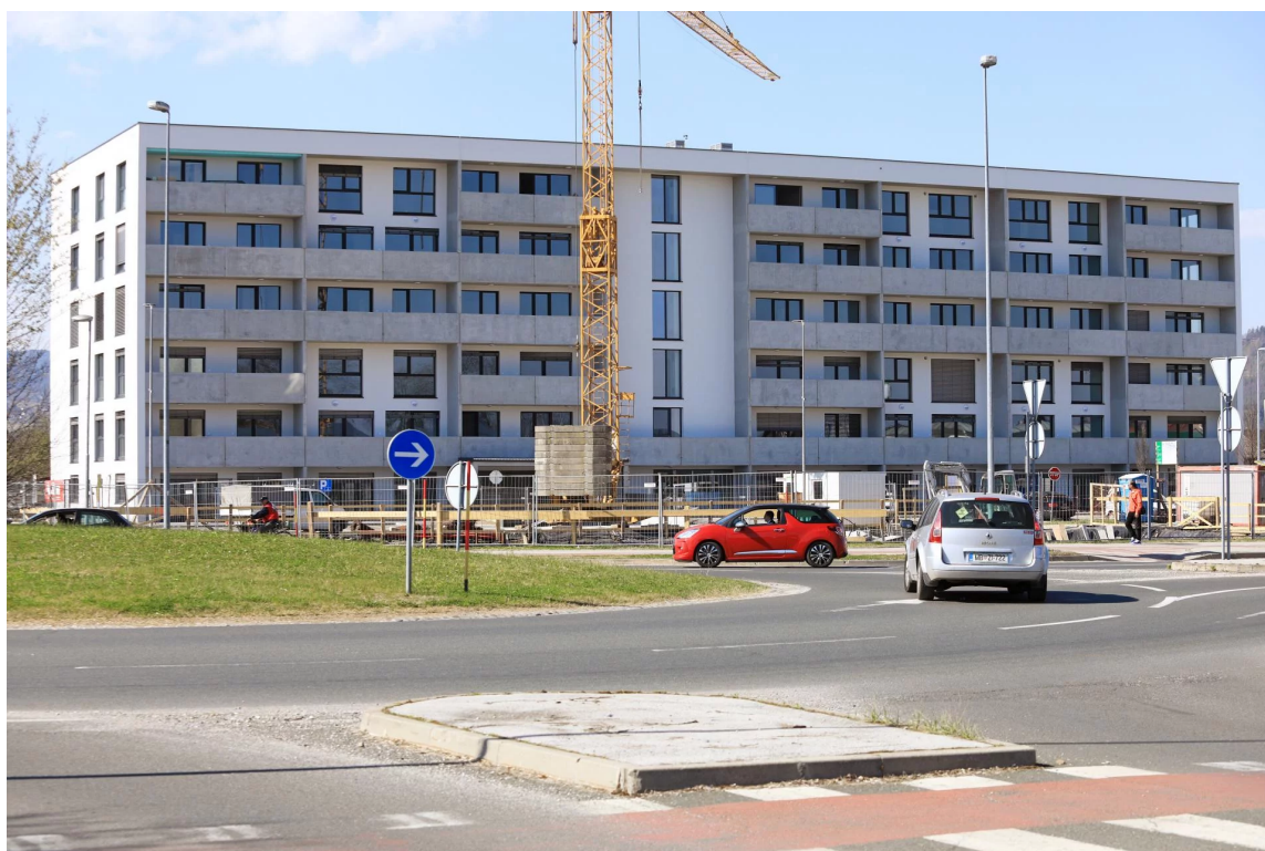
Gradnja bloka ob Studenški ulici ANDREJ PETELINŠEK
