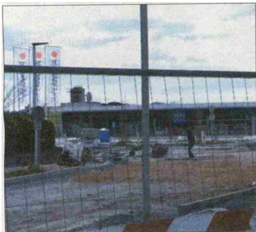
Gradnja krožišča se nadaljuje
