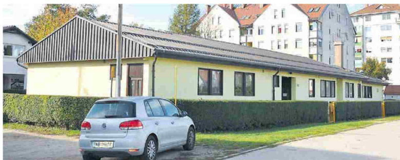
Vrtec, obstoječe stanje.
