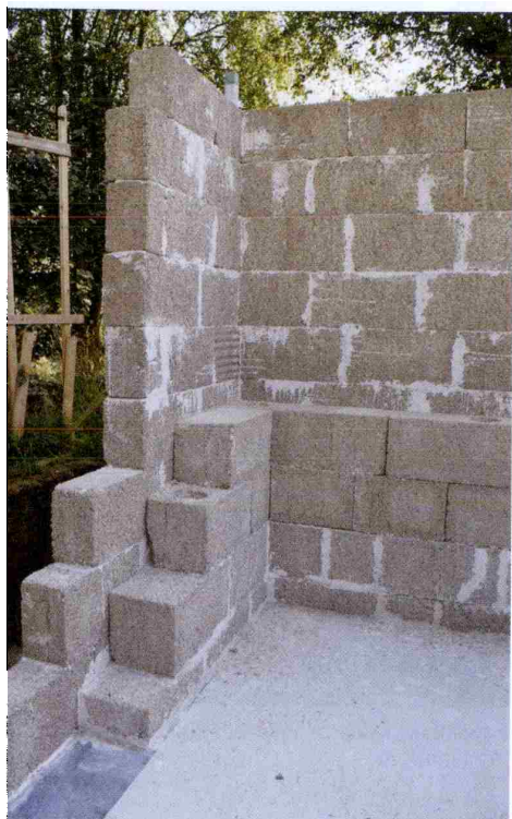
Gradnja s konopljenimi zidaki (foto Hempcrete)
