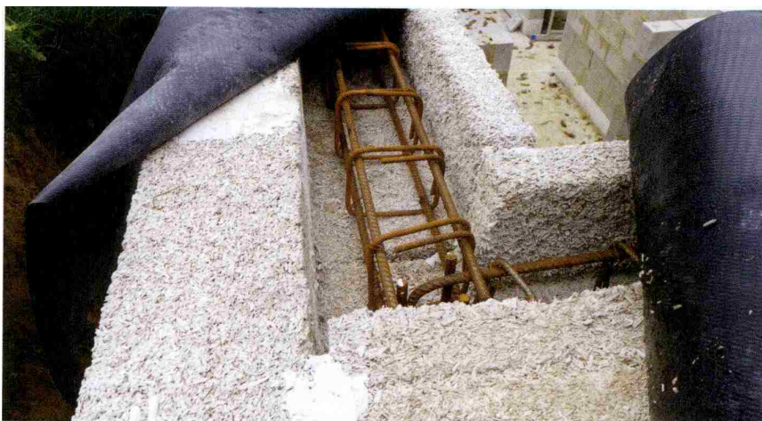
Oblikovani konopljeni bloki omogočajo vgradnjo ojačitev.
