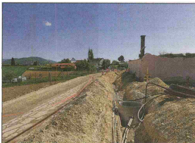
Izgradnja pločnika ob regionalni cesti skozi Zdole
