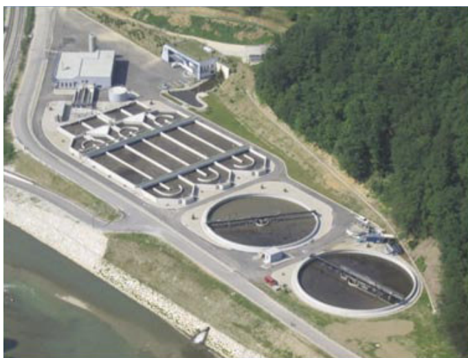
Slika 21 • Čistilna naprava Celje, 80.000 PE, z nitrifikacijo, denitrifikacijo, defosfatizacijo in brez anaerobnih reaktorjev za stabilizacijo blata
