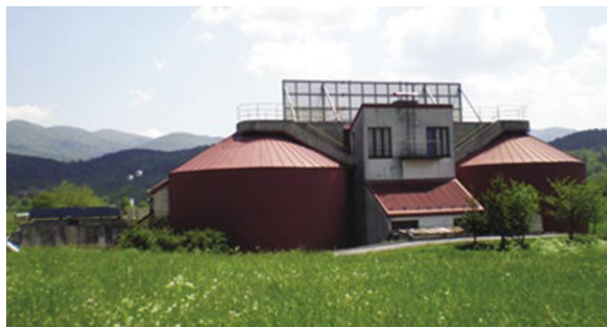
Slika 18 • Anaerobni reaktorji čistilne naprave v Postojni brez nitrifikacije/denitrifikacije efluenta
