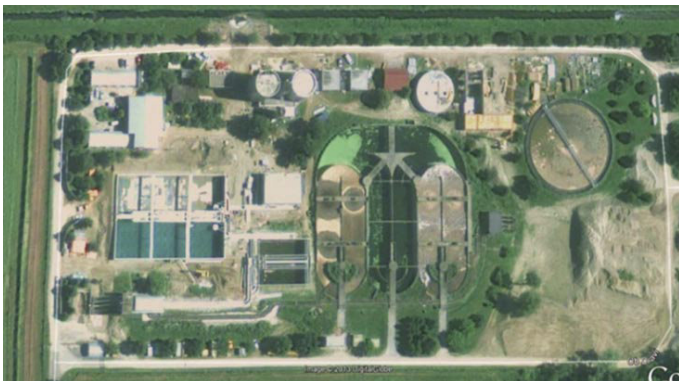
Slika 15 • Začetek gradnje nove, tretje čistilne naprave SBR
