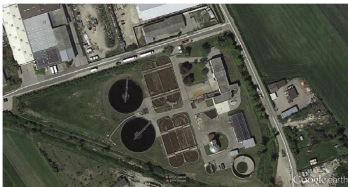
Slika 17 • Čistilna naprava Eisenstadt (Železno) v sosednji Avstriji za zaščito, Nižiderskega jezera (Neusiedler See)
