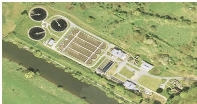
Slika 12 • Čistilna naprava Kettingen na Ruhru. Nitrifikacija in denitrifikacija brez anaerobnih reaktorjev
