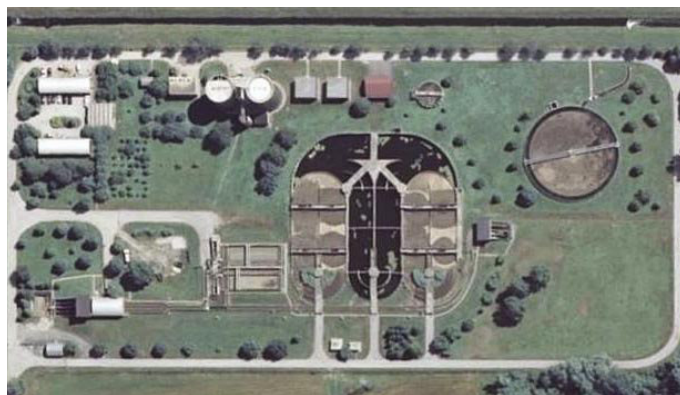
Slika 9 • Rekonstrukcija prvotno načrtovane in zgrajene naprave. Z opustitvijo anoksičnega reaktorja – črnega dela na sredini – so prvotno prostornino biološkega reaktorja zmanjšali na polovico
