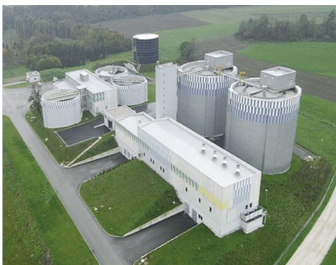
Slika 19 • Čistilna naprava Ljubljana. Nepotrebni anaerobni reaktorji in sušilnika za sušenje blata z energijo bioplina, namesto direktnega sežiga z lastno energijo organske mase blata
