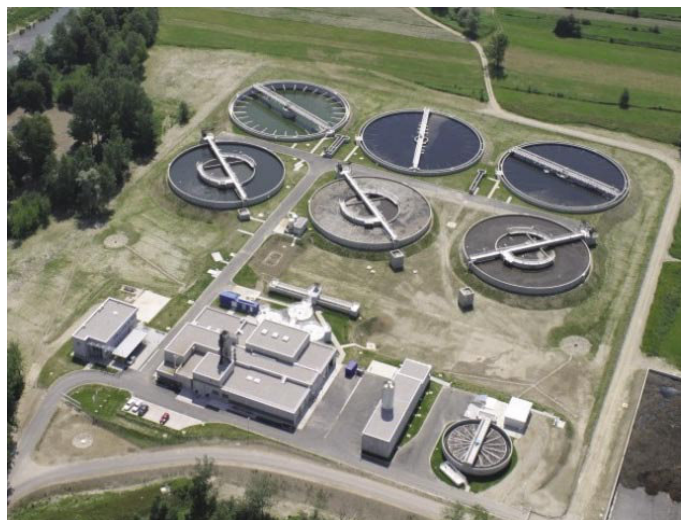
Slika 22 • Čistilna naprava Maribor, 230.000 PE, z nitrifikacijo, denitrifikacijo in defosfatizacijo, brez anaerobne stabilizacije blata, zgrajena po predlogu avtorja članka
