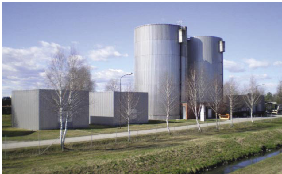
Slika 10 • Namesto male HE z močjo 2000 do 3000 kW v Markovcih so za 180 kW zgradili dražje primarne usadalnike in gnilišča, s porušljivo anoksičnega dela pa napravo osiromašili za denitrifikacijo
