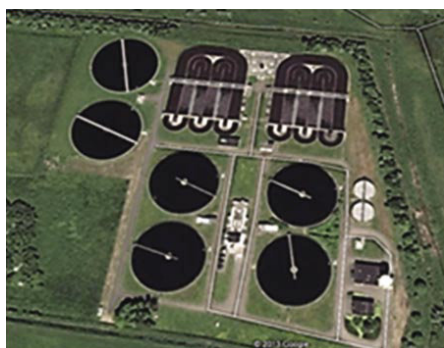
Slika 4 • Čistilna naprava, 200.000 PE, Zwijndrecht na Nizozemskem z nitrifikacijo in denitrifikacijo brez anaerobnih reaktorjev
