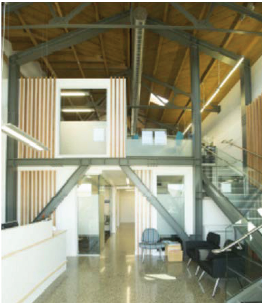
Slika 23 • Z vidnim jeklenim okvirjem utrjena stavba.
