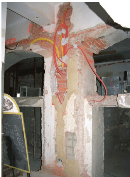
Slika 19 • Primer nevarne oslavitve konstrukcije.
