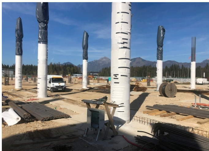
Slika 15 • Zaščita in nega AB-stebrov po razopazanju.
