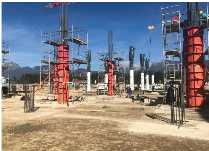
Slika 14 • Opaženje AB-stebrov.
