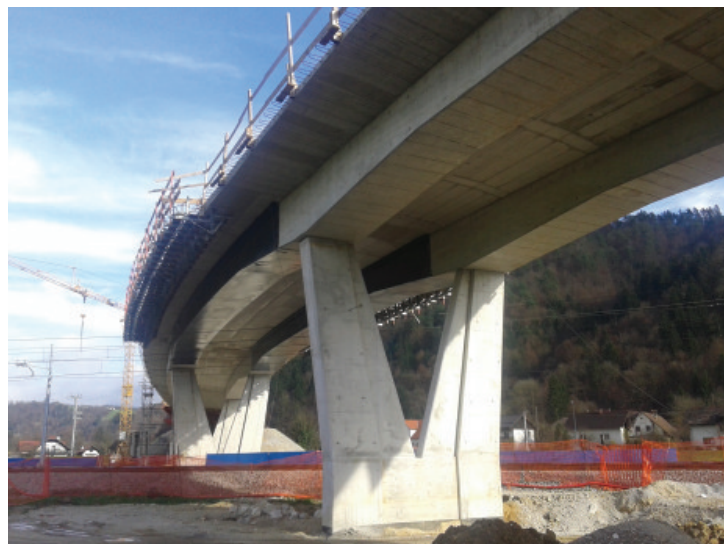
Slika 16 • Sovprežna prekladna plošča nad železniško progo
