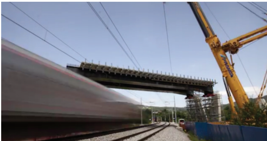
Slika 1 • Prevoz vlaka takoj po končani montaži jeklenih nosilcev
