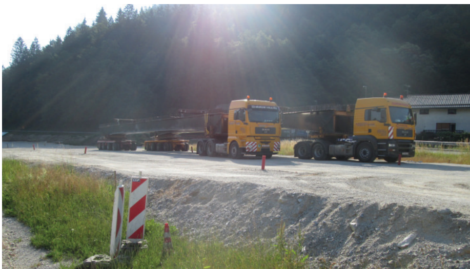
Slika 5 • Dovoz jeklenih nosilcev na gradbišče
