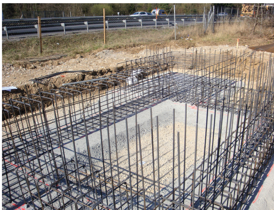
Slika 9 • Priprava armiranobetonskih temeljev ob avtocesti.
