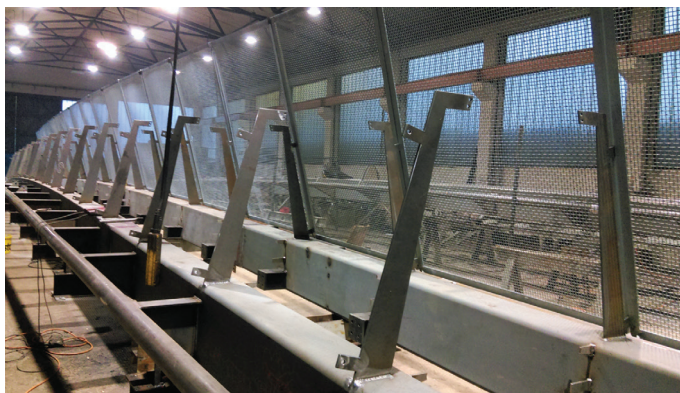
Slika 10 • Izdelava konstrukcije mostu v delavnici.
