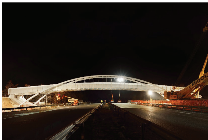
Slika 12 • Nočni dvig mostu. (Foto: M. Kambič)
