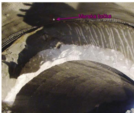
Slika 18 • Prikaz vgrajene merske točke v stropu kalote desne cevi predora (Vir: arhiv SCT, avtor Marko Venta)
