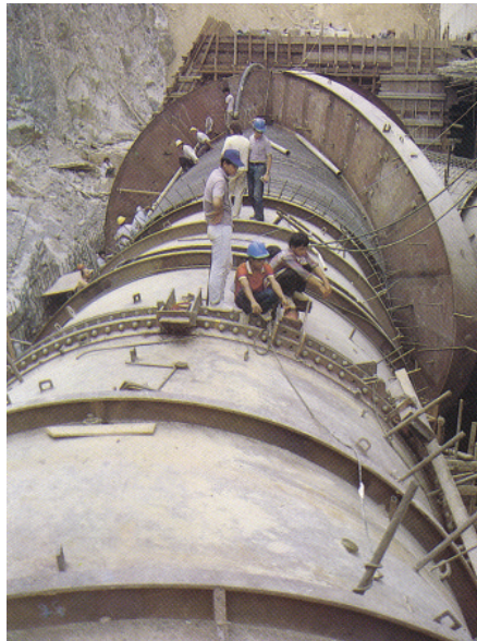
Slika 1 • Gradnja tlačnega cevododa Chiew Larn, Tajska
