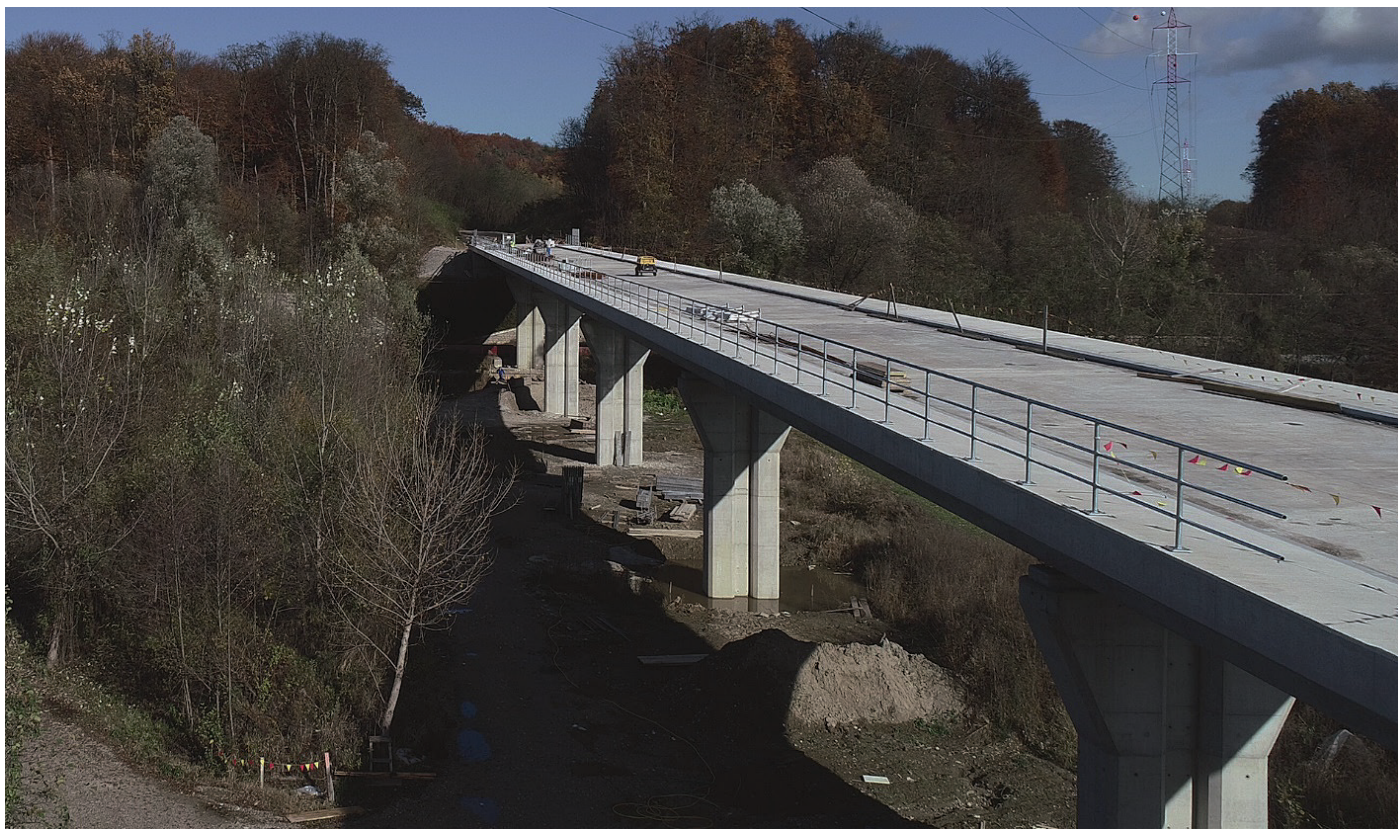
Slika 32 • Viadukt v fazi gradnje.
