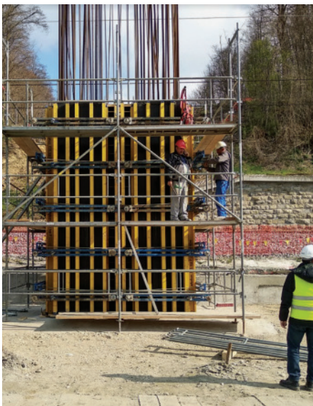
Slika 14 • Opaž spodnjega dela stebra.
