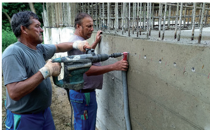
Slika 21 • Vrtanje lukenj za sidrno armaturo.
