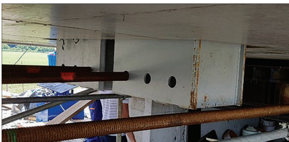
Slika 28 • Dela vlečnih trnov, ki segata izpod spodnje plošče prekladne konstrukcije.
