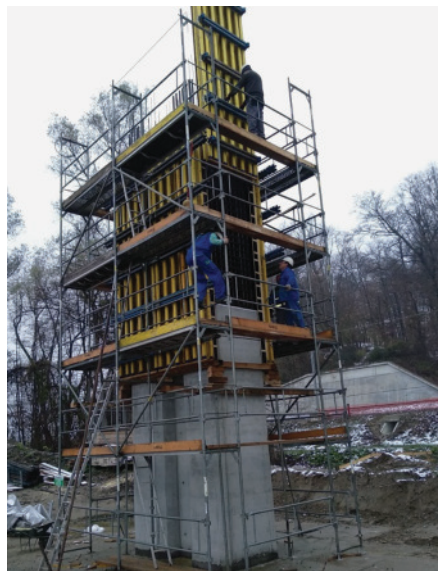
Slika 15 • Opaž vmesnega dela stebra.
