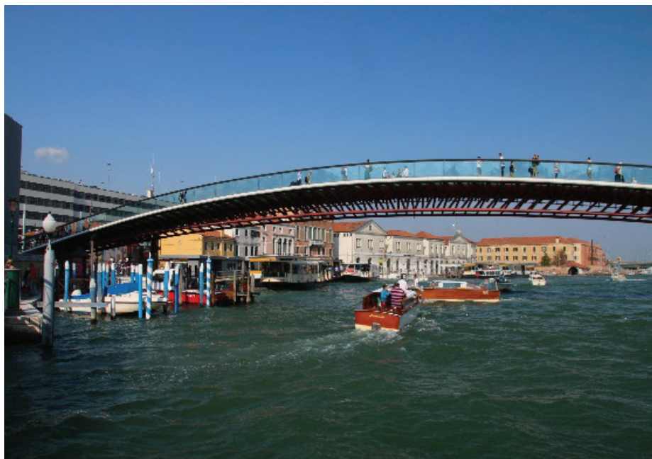
Slika 4 in 5 • Jekleni lok z razponom 81 m ima pohodno površino v večjem delu pokrito s steklom. (Foto: G. Humar).
