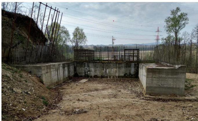
Slika 19 • Delno zasut opornik v osi 7.
