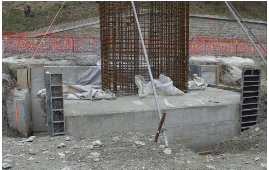
Slika 13 • Temeljna blazina v osi 6.
