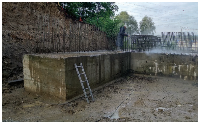
Slika 20 • Čiščenje betonskih površin z vodnim curkom.
