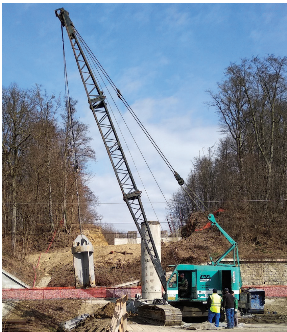
Slika 11 • Izvedba pilotov Benotto v osi 6.
