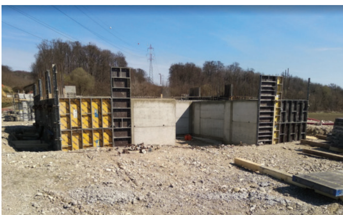
Slika 17 • Gradnja opornika v osi 1.
