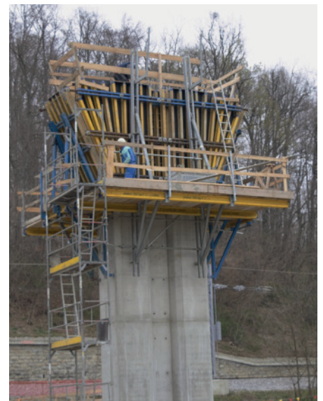
Slika 16 • Opaž razširjenega zgornjega dela stebra.
