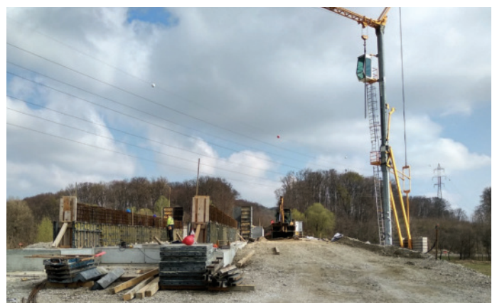
Slika 18 • Gradnja narivne delavnice v osi 1.
