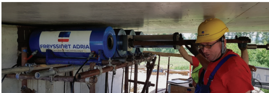
Slika 27 • Vlečni votli hidravlični cilindri z vijaki Freyssibar.
