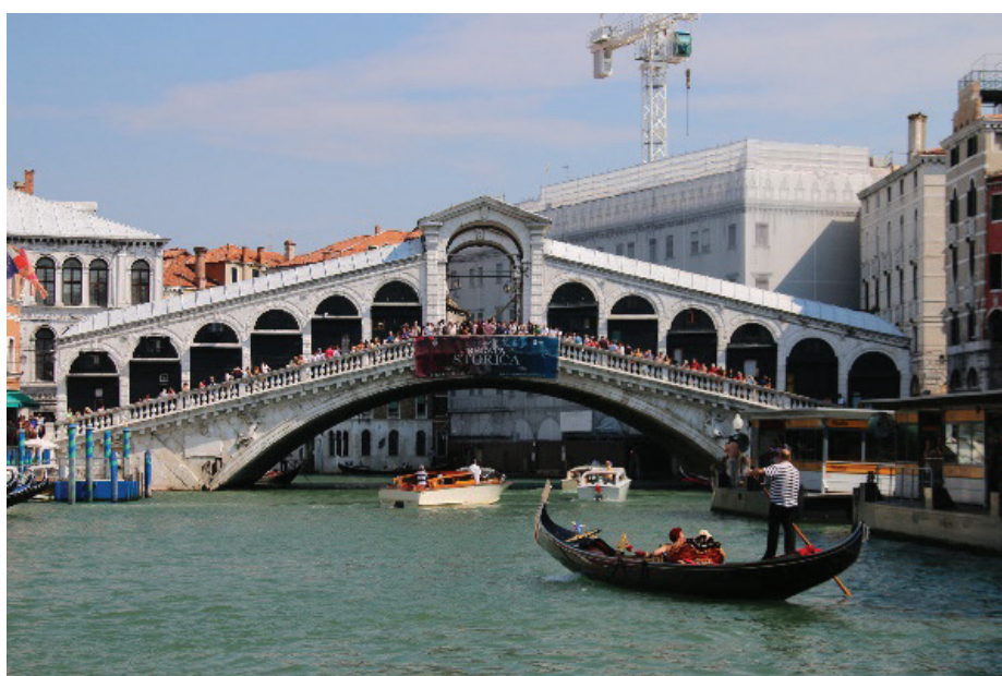
Slika 2 in 3 • Most Rialto iz leta 1591 z razponom loka 28 m je temeljen na lesenih kolih. Po 6000 kolov so vgradili na vsaki strani Canala Grande vse do globine 9 m pod vodno gladino. (Foto: G. Humar).
