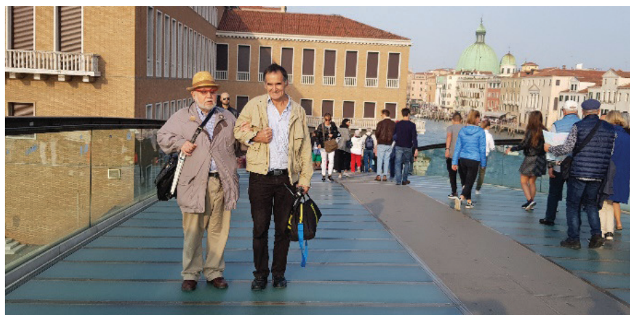
Slika 6 in 7 • Stekljeno površino so morali zaradi številnih zdrsov pešcev popeskati in zato steklo ni več prozorno. (Foto: G. Humar).
