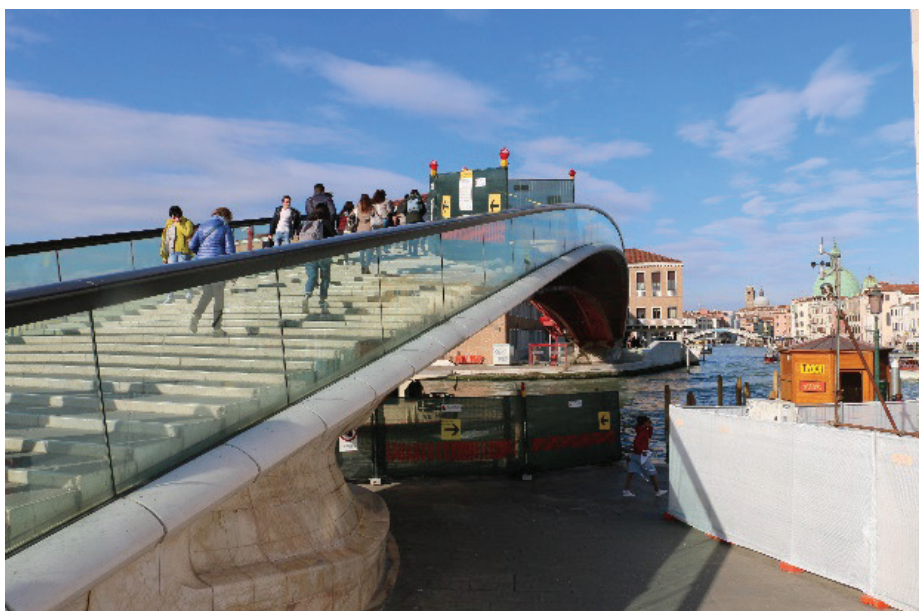
Slika 8 in 9 • Na mostu potekajo stalna popravila steklenih stopnic. Ob sneženju most preprosto zaprejo za promet. (Foto: G. Humar).
