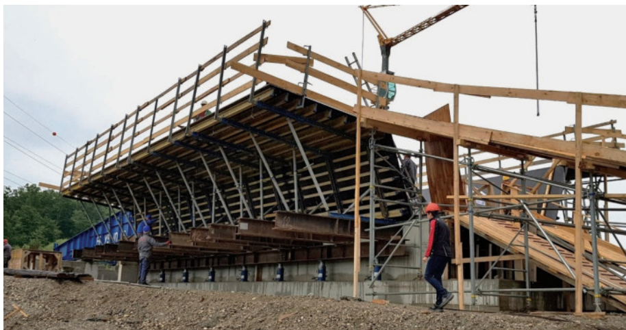
Slika 25 • Pogled na končano delavnico za narivanje.
