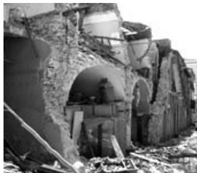
Slika 3 • Zunajravninska porušitev zidov zaradi a) slabe povezanosti konstrukcijskih elementov ( http://db.nzsee.org.nz/Seminars/2014/Lagomarsino_Wellington_2014-2-20.pdf ) in b) slabe povezanosti zidovine (Silva et al., 2014), L'Aquila, Abruzzo, Italija, c) porušitev stropa bazilike sv. Frančiška Asiškega v Assisiju med potresom v regiji Umbria-Marche leta 1997 ( http://projecthistoryitalia.altevista.org/26-settembre-1997-terremoto-nelle-marche-e-in-umbria/ )
