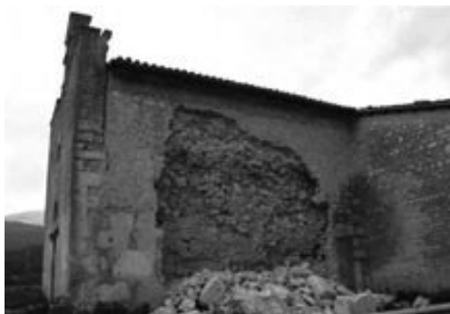
Slika 3 • Zunajravninska porušitev zidov zaradi a) slabe povezanosti konstrukcijskih elementov ( http://db.nzsee.org.nz/Seminars/2014/Lagomarsino_Wellington_2014-2-20.pdf ) in b) slabe povezanosti zidovine (Silva et al., 2014), L'Aquila, Abruzzo, Italija, c) porušitev stropa bazilike sv. Frančiška Asiškega v Assisiju med potresom v regiji Umbria-Marche leta 1997 ( http://projecthistoryitalia.altevista.org/26-settembre-1997-terremoto-nelle-marche-e-in-umbria/ )
