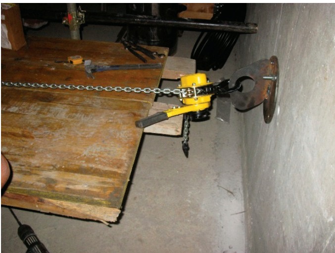
Slika 6 • Odstranjevanje ležišča z verižnim škripcem (levo), sproščeni ležiščni prostor (desno).
