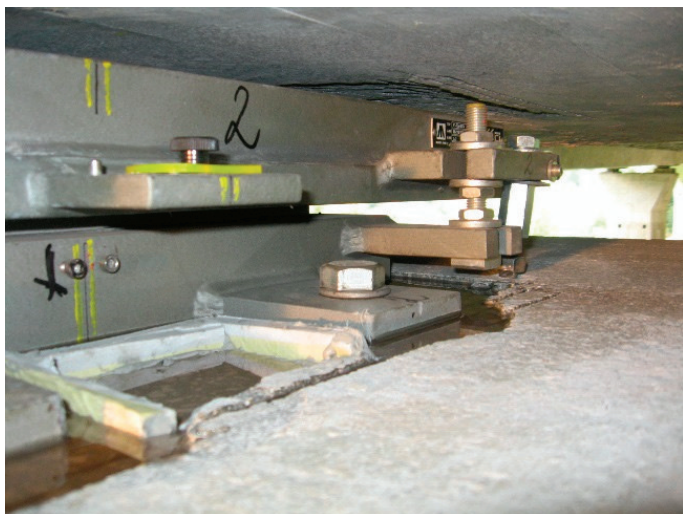
Slika 8 • Po fini nastavitvi lege ležišča je bila izdelana spodnja zalivka z epoksimalto (levo), injektiranje zgornje rege (desno).
