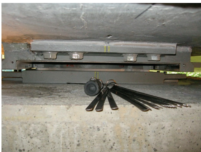
Slika 9 • Meritev drsne reže ležišča (levo), meritev ravnosti s tritočkovno precizno vodno tehtnico (desno).
