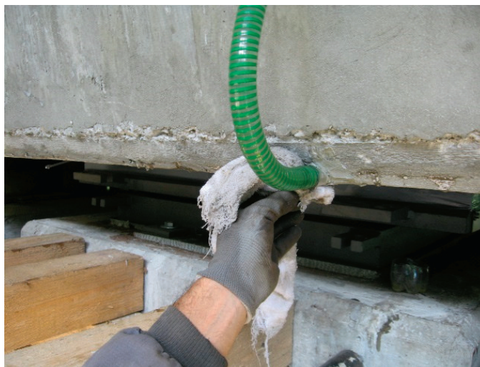
Slika 8 • Po fini nastavitvi lege ležišča je bila izdelana spodnja zalivka z epoksimalto (levo), injektiranje zgornje rege (desno).
