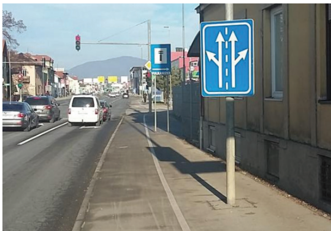
Slika 3 • Levo – Neprimerno postavljena signalizacija ne zagotavlja zaznavanja; desno – usmerjalni pasovi brez predhodne informacije za voznika o razvrščanju in smereh.
