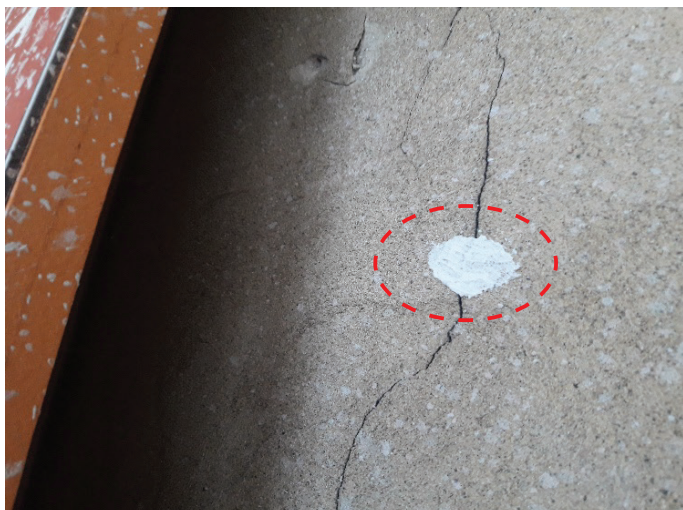
Slika 13 • Nameščene kontrolne plombice preko karakterističnih razpok v obodnem zidovju in obokanih stropih arkadnih hodnikov Stare grofije.
