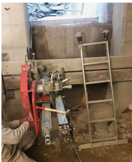
Slika 12 • Strojni izrez armiranobetonskih in prehodno injektiranih opečno-kamnitih zidov.
