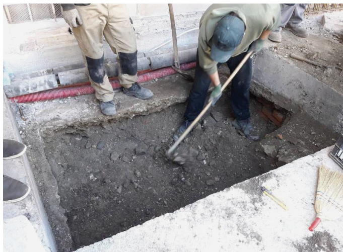
Slika 8 • Pričetek izkopa prve vertikalne kampade južne podzemne povezave.
