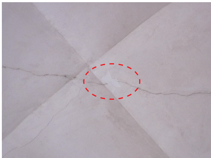
Slika 13 • Nameščene kontrolne plombice preko karakterističnih razpok v obodnem zidovju in obokanih stropih arkadnih hodnikov Stare grofije.
