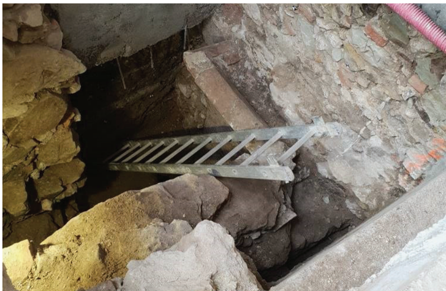
Slika 11 • Izkop globljih vertikalnih karnadov, vidni so ostanki stropnega oboka srednjeveške kleti ter lokalno izžagano kamnito-opečno gradivo.
