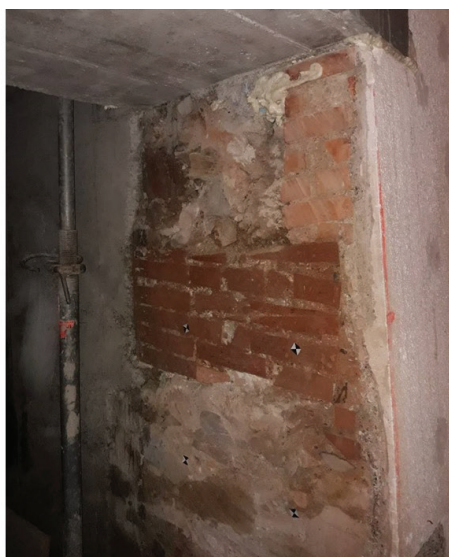
Slika 12 • Strojni izrez armiranobetonskih in prehodno injektiranih opečno-kamnitih zidov.
