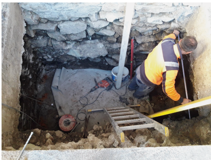
Slika 9 • Območje izkopa globljih vertikalnih kampad podzemnih povezav.
