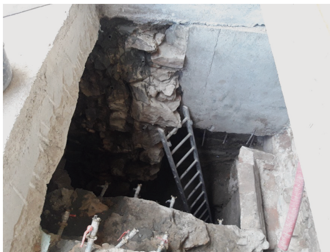
Slika 10 • Izkop globljih vertikalnih kampad, vidni so injekcijski nastavki, preko katerih se je injektiralo med izkopi odkrito kamnito-opečno gradivo.
