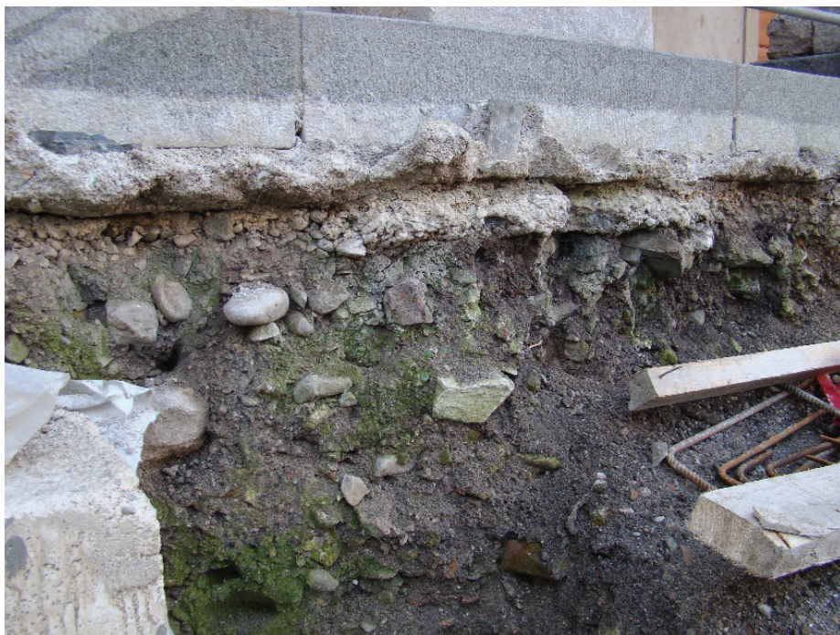
Slika 3 • Temeljna tla na območju temeljenja stebrov arkadnih hodnikov.
