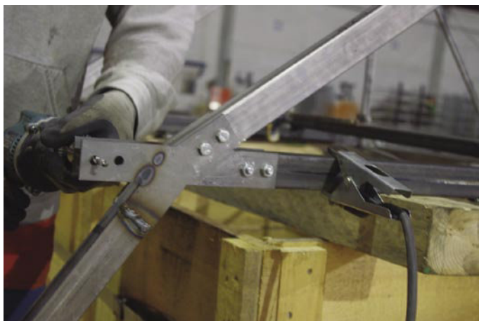
Slika 12 • Vijačni stik nosilnih elementov
