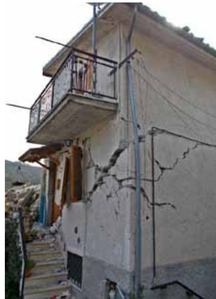
Slika 6 • Značilne diagonalne strižne razpoke v pritličju.
