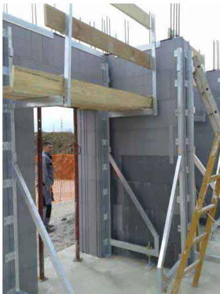
Slika 7 • Sistemske komponente JUBHome WALL.
