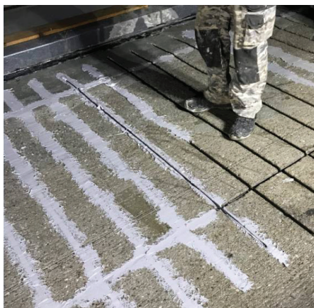
Slika 8 • Vgradnja karbonskih palic.
