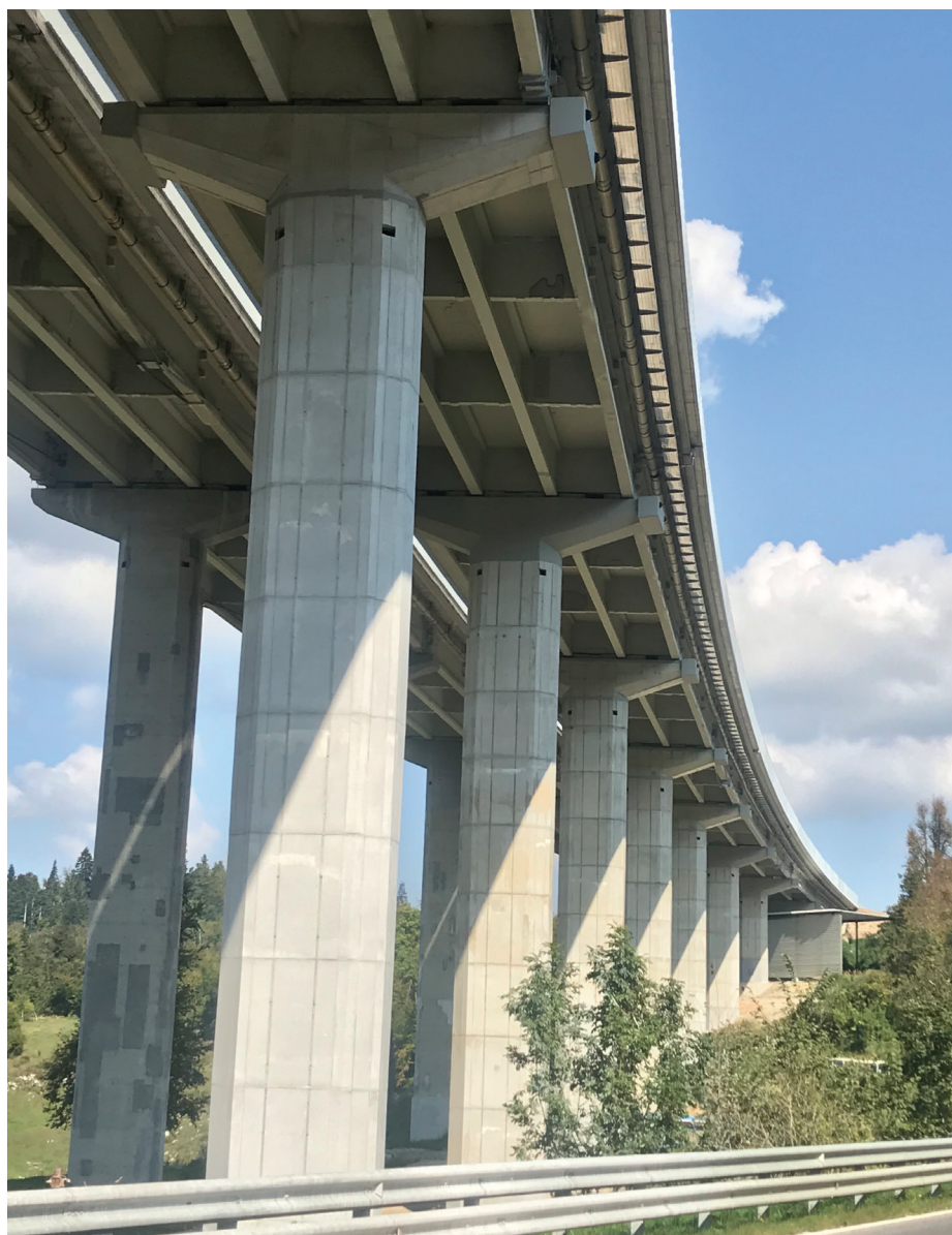
Slika 9 • Spodnja stran viaduktov Ravbarkomanda po obnovi.
