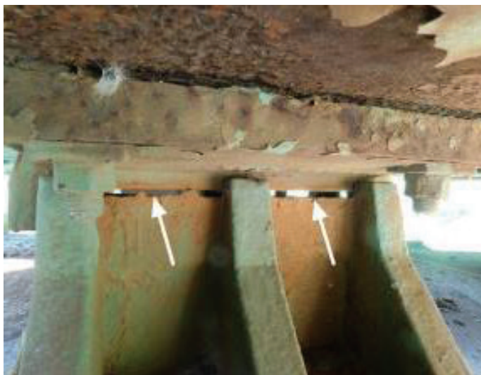
Slika 5 • Zračnost ležišč (9 mm in 8 mm).
