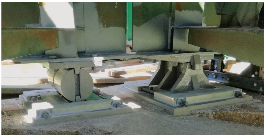
Slika 16 • Končno stanje obnovljenih ležišč (protikorozijska zaščita preklade še ni zaključena).
