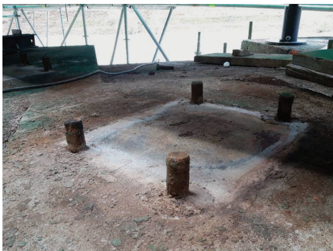
Slika 12 • Stanje na mestu ležišča po odstranitvi ležišč in svinčene plošče.
