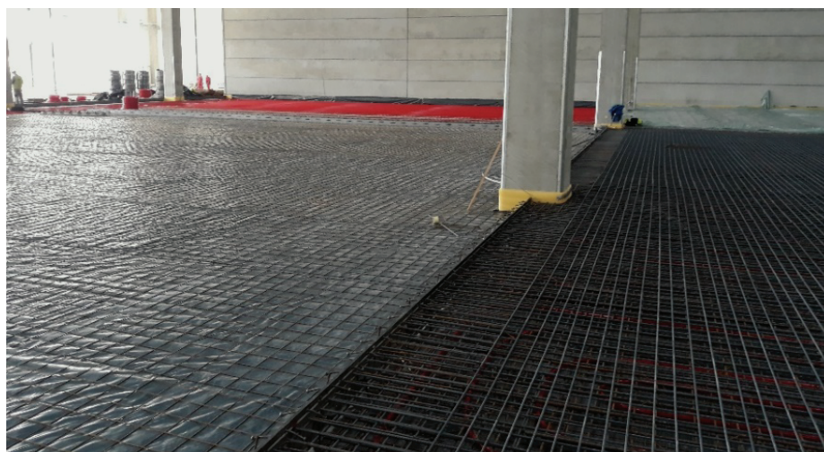
Slika 5 • Vgrajevanje drsnih membran industrijskega tlaka, razvod talnega grejja ter pripravljena armatura industrijskega tlaka.
