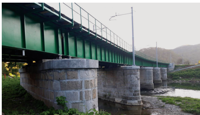
Slika 22 • Most po sanaciji.
