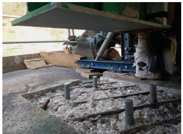
Slika 13 • Priprava betonske in jeklene površine na vgradnjo obnovljenih ležišč.
