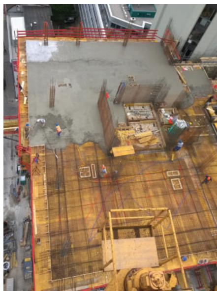
Slika 16: Betoniranje AB-plošče, pogled z žerjava.
