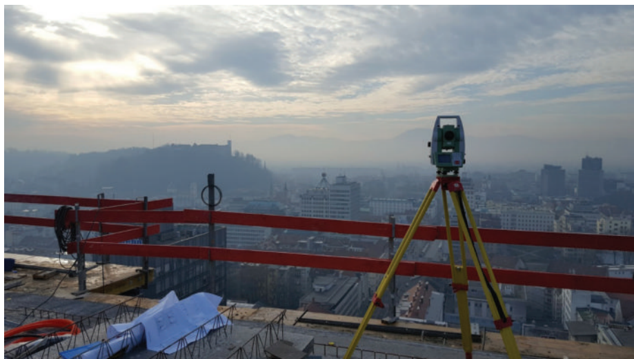
Slika 31: Geodetska spremljava gradnje.
