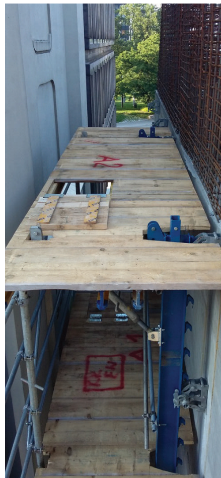
Slika 21: Plezajoči opaž Xclimb 60.
