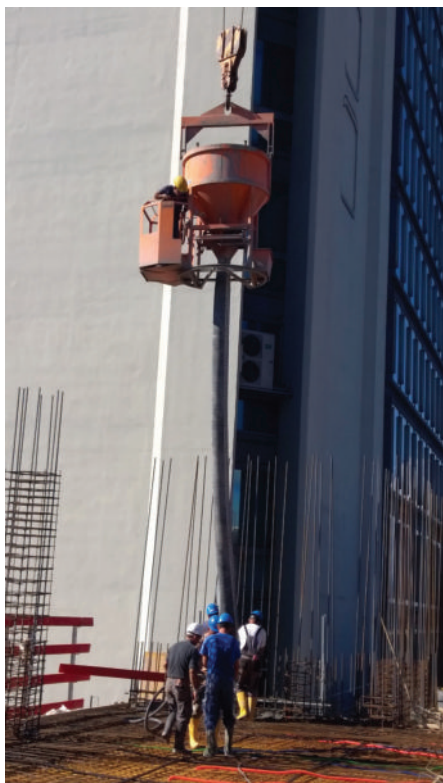
Slika 13: Betoniranje AB-plošče s pomočjo kible.
