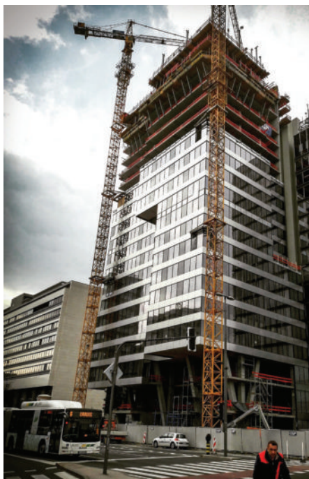
Slika 22: Gradnja zgornjih etaž in montaža fasade (spodaj).
