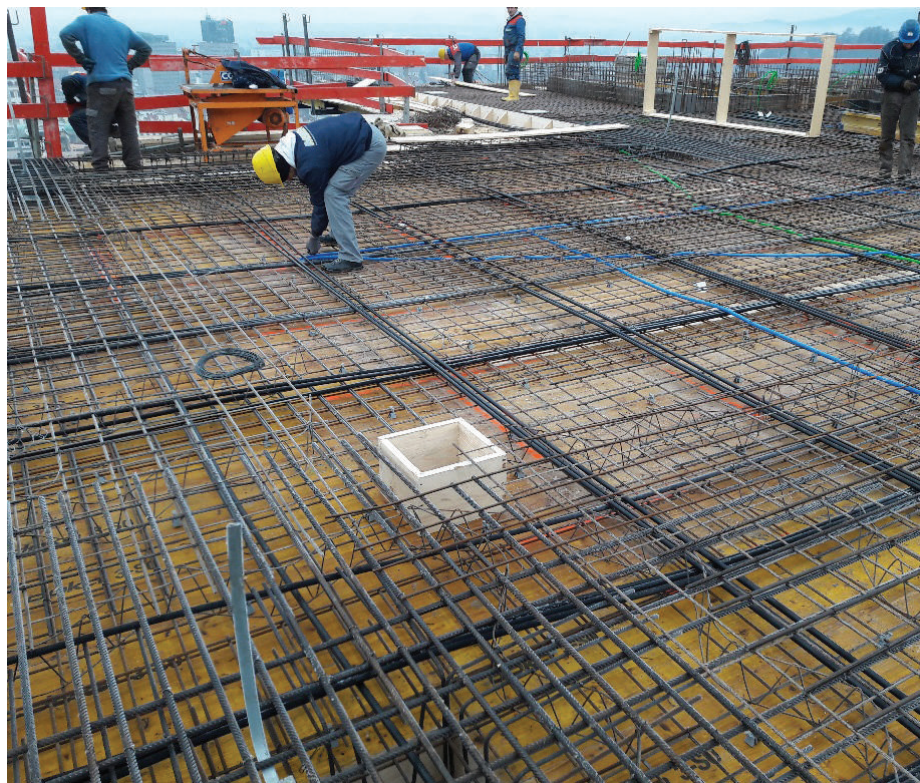
Slika 14: Polaganje armature in kablov za prednapenjanje ter zaščitnih cevi inštalacij pred betoniranjem plošče.
