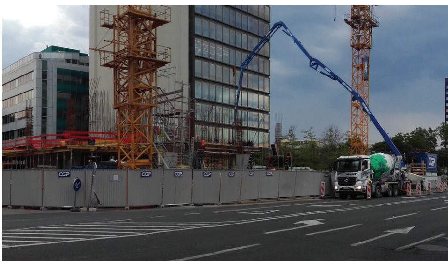
Slika 12: Betoniranje plošče nad pritličjem.
