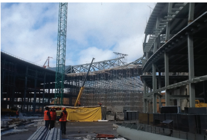
Slika 8 • Montaža enega od strešnih mostov.
