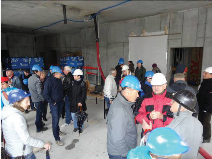
Slika 3 • Na gradbišču Hotela Intercontinental, LJ.
