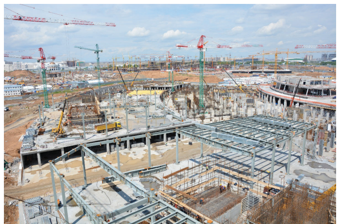
Slika 9 • Gradbišče objektov C4 in C3, v ozadju drugi objekti v sklopu EXPA.
