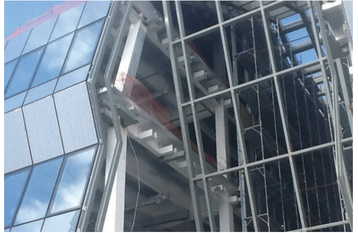
Slika 5 • Konstrukcija in fasadni pas internacionalnega objekta.
