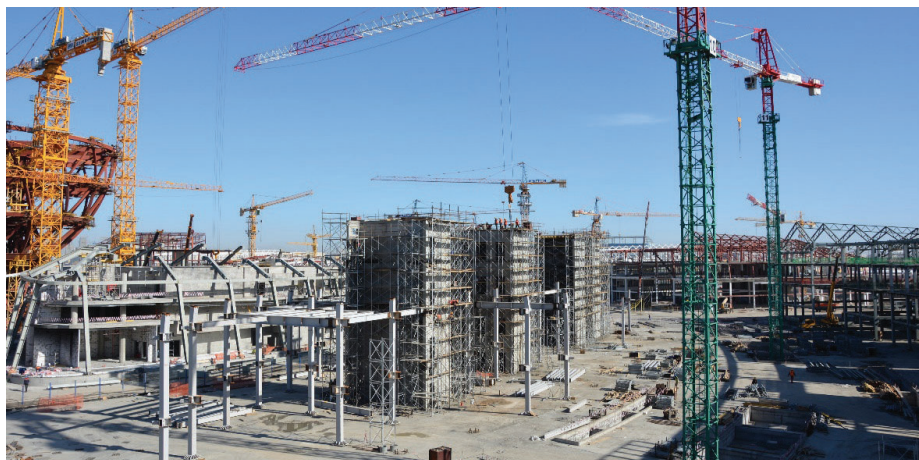
Slika 10 • Gradnja tematskega paviljona.
