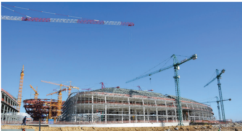
Slika 3 • Gradbišče kompleksa C3.
