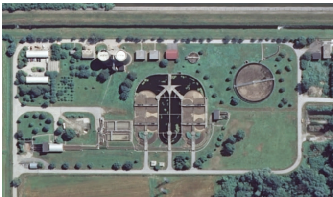
Slika 20 • Namesto da bi za pogon č. n. z izgradnjo male HE na jezcu v Markovcih izkoristili 3000 kW vodne moči, so za manjšo porabo energije opustili denitrifikacijo (črni del). Namesto male HE pa na č. n. zgradili dražjo bioplinarno za le 180 kW.
