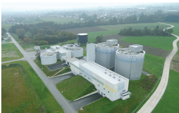
Slika 24 • Gnilišča za negospodarno proizvodnjo bioplina za sušenje blata v sušilnem bobnu s pripadajočimi objekti in napravami.
