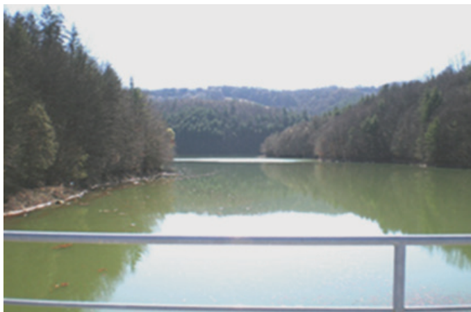
Slika 9 • Izpust in preliv akumulacije Mola.
