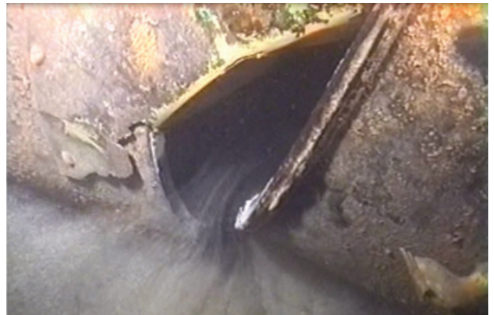
Slika 5 • Namerno nasilno narejena odprtina na zahodnem kraku natege (poleg drugih na vzhodnem kraku), s katero so nategi preprečili odvzemanje onesnažene vode z dna jezera ((Rismal, 1999), (Rismal, 2004), (Rismal, 2011))
