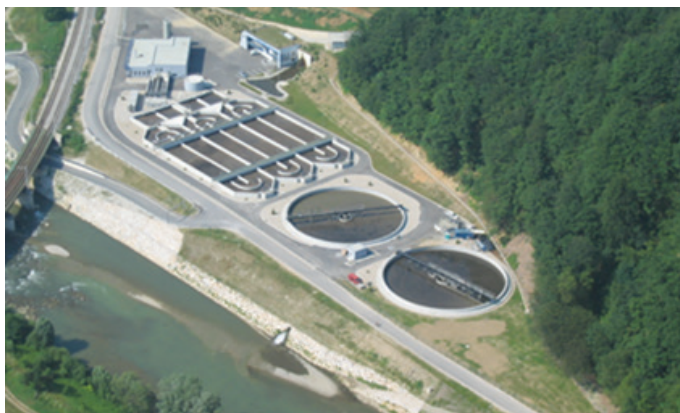
Slika 26 • Tehnološko-ekonomsko utemeljena čistilna naprava za Celje 80.000 PE z denitrifikacijo in defosfatizacijo je podobna tisti, ki je bila zgrajena 1980. na Ptujju.
