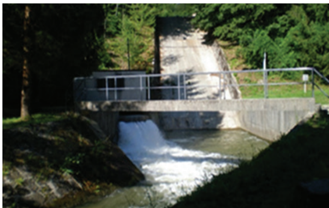
Slika 8 • Izpust in preliv akumulacije Mola.
