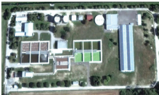
Slika 21 • Ko so predpisi zahtevali denitrifikaciji, so napravo na sliki 20 porušili in zgradili novo, že tretjo č. n., tokrat vrste SBR, toda brez obveznih izravnalnih bazenov.
