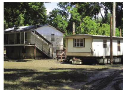
Slika 4 • Obstoječi hiši v južni Louisiani so dodani plovni temelj in vodila (levo); desno je razvidno, da je amfibijska hiša prestala poplavo nepoškodovana v primerjavi s poplavljeno hišo, grajeno na terenu ((English, 2009), (English, 2015))
