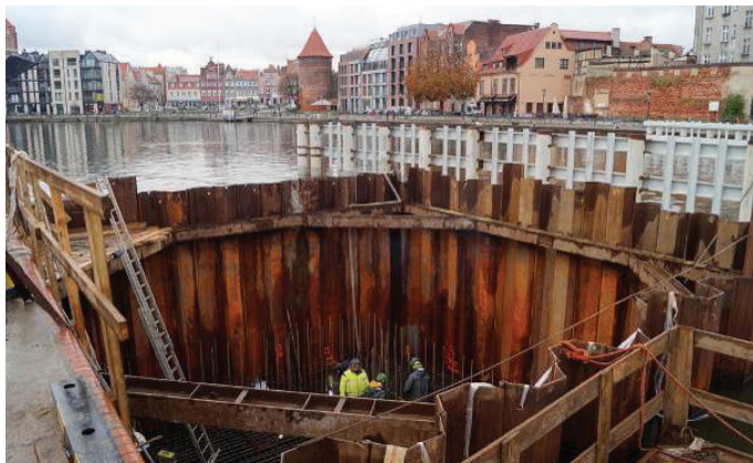
Slika 11 • Gradbišče jeseni 2016 in izdelava jeklene konstrukcije v delavnici.
