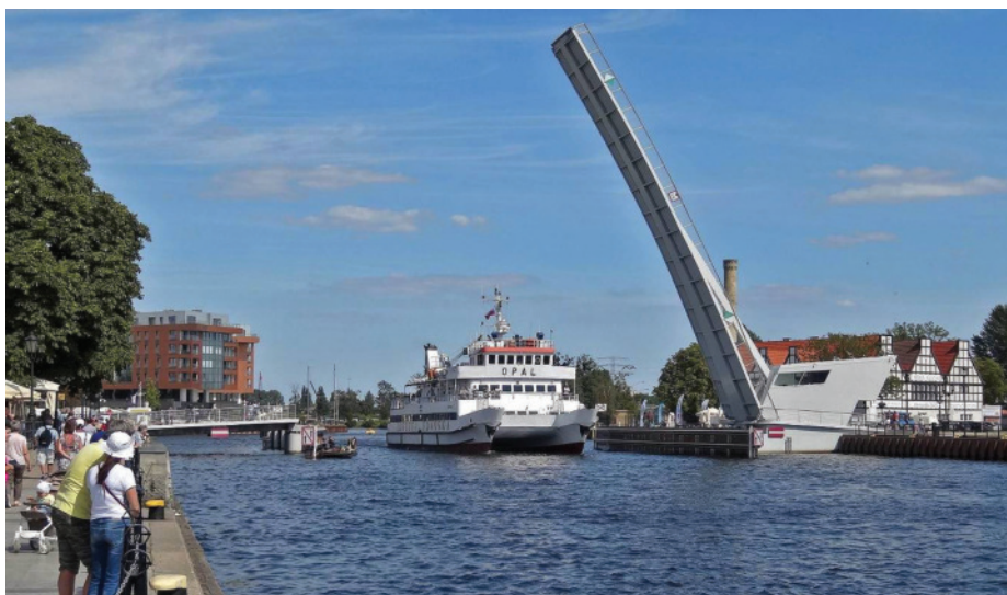
Slika 15 • Pogled na dvignjen most s strani starega mestnega jedra.
