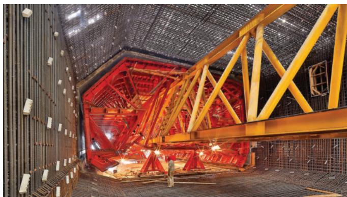
Slika 5 • Hidravlični opažni sistem se pomika znotraj armaturne kletke cevi predora. (Foto: PERI)
