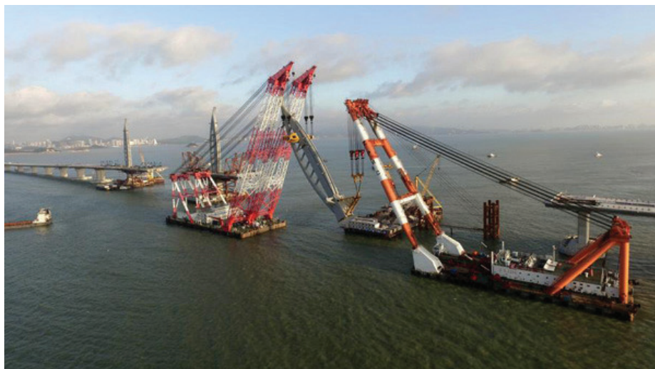
Slika 3 • Postavljanje pilona. (Foto: China Daily)
