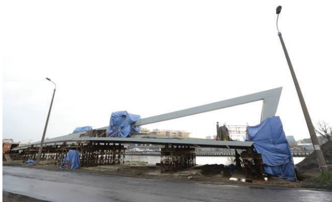
Slika 12 • Poskusna in končna montaža jeklene konstrukcije na gradbišču.
