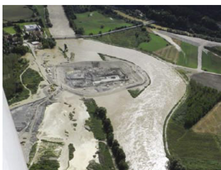
Slika 9 • Fotografija območja gradbene jame in obtočnega kanala ob visokih vodah septembra 2014 (pretok ca. 2000 m 3 /s) (Vir: 24ur.com)
