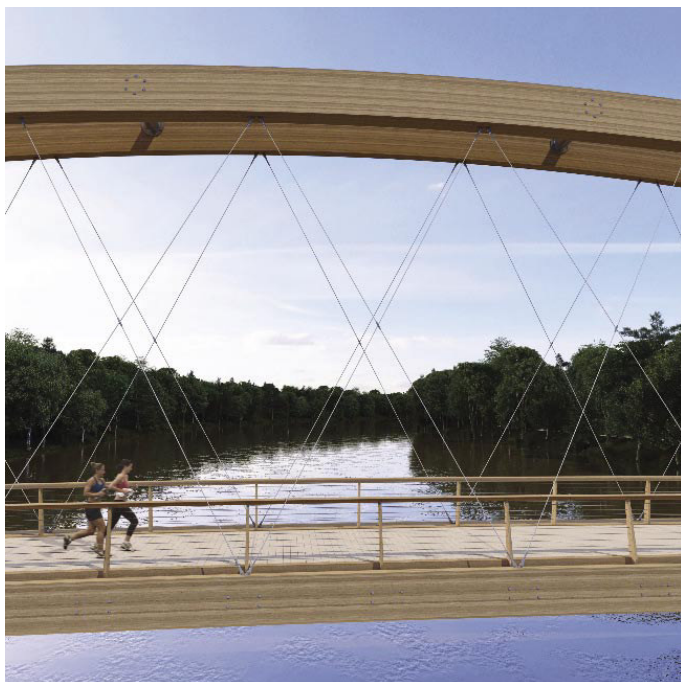
Slika 5 • Poševne jeklene vezi med lokom in spodnjim nosilcem
