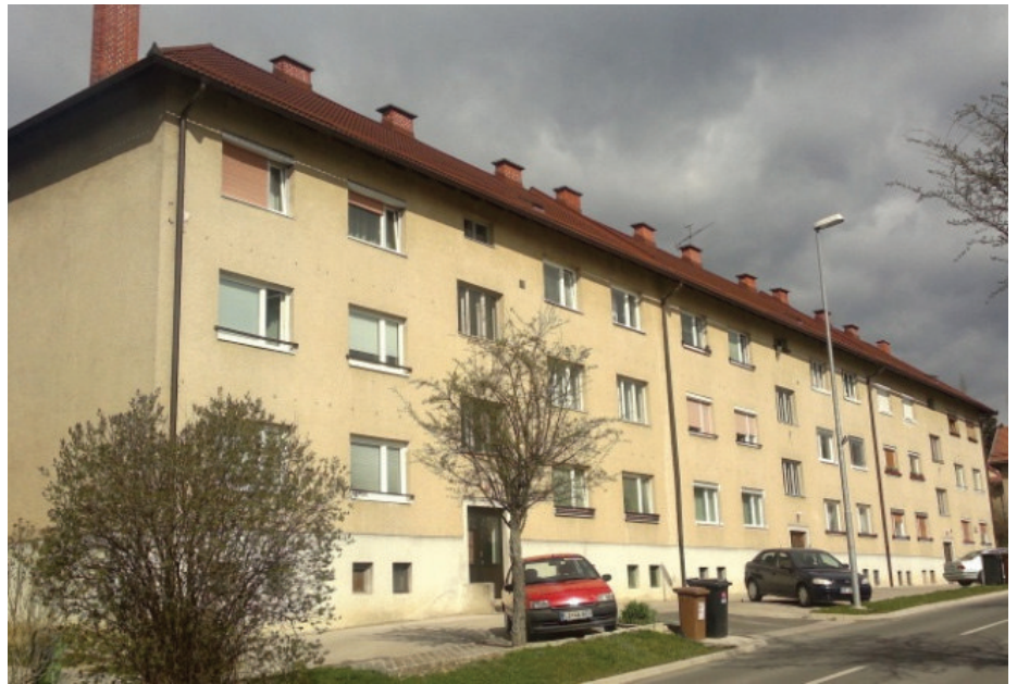
Slika 2 • Večstanovanjska stavba A.
