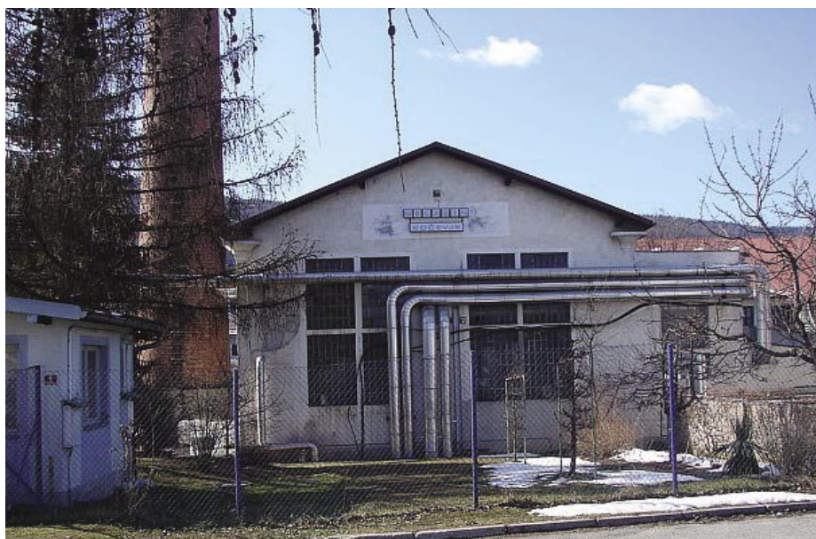
Slika 1 • Stara kotlovnica podjetja Melamin, d. d., Kočevje
