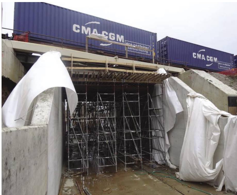
Slika 1 • Gradnja AB-podvoza Jablane (Fotografija: Jože Preskar)
