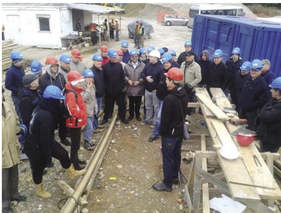
Slika 2 • Predstavitve gradbišča železniškega nadvoza v Zgornji Hajdini (Fotografija: Dušan Jukić)
