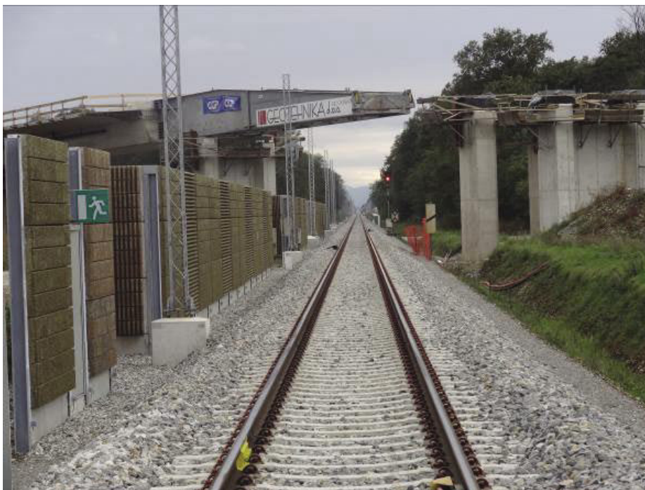
Slika 3 • Gradbišče železniškega nadvoza v Zgornji Hajdini (Fotografija: Jože Preskar)
