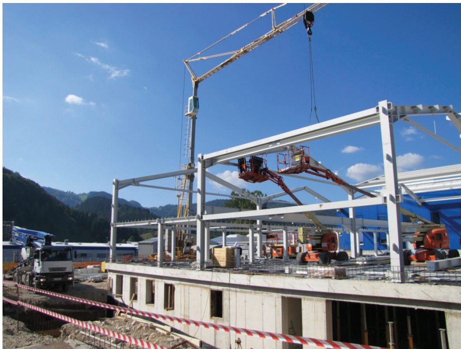
Slika 2 • Pogled na gradbeno mehanizacijo, ki so jo uporabljali pri gradnji (črpalka za beton, visoki žerjav, teleskopske dvizne ploščadi)
