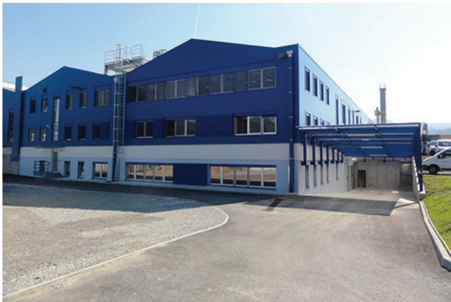
Slika 1 • Produkt – industrijska hala 4 in parkirišče Investitor objekta je bila družba, katere dejavnost je proizvodnja elementov za fluidno tehniko. Proizvajajo različne hidravlične ventile, kompresorje in črpalke. Zaradi širitve proizvodnje in prostorske stiske so se v podjetju odločili za širitev in novogradnjo industrijske hale 4 in parkirišča. Objekt je dimenzij 30 m x 40 m in se danes uporablja za proizvodnjo omenjenih delov. V objektu so pisarne, skladišče, proizvodne linije, garderobe in sanitarije
