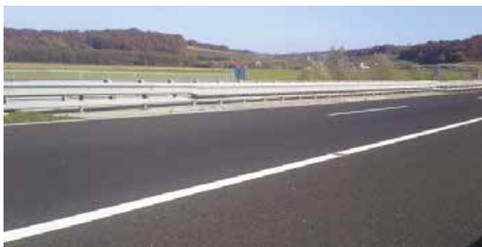
Slika 21 • Odbojna ograja na manjšem mostu na AC.
