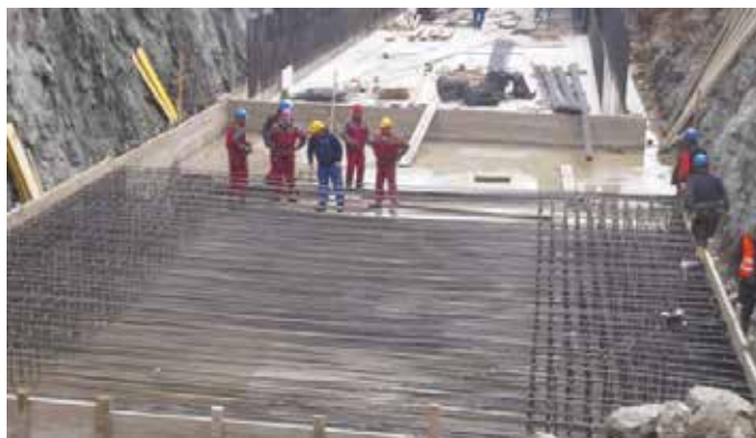
Slika 10 • Fotografija strižne armature v talni plošči AB-okvirja.
