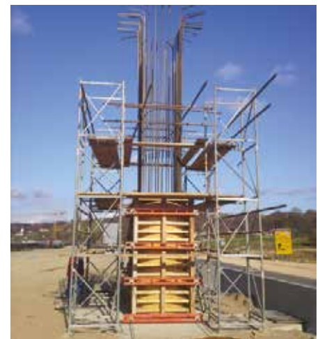
Slika 34 • Oder za podpiranje armature.
