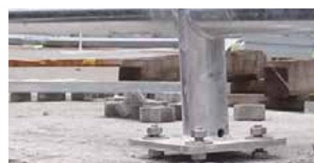
Slika 28 • Ustrezni detajli pritrjevanja pred podlivanjem.
