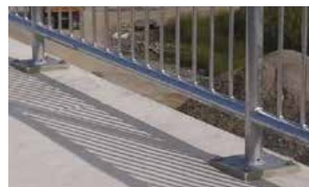
Slika 29 • Ustrezni detajli pritrjevanja po podlivanju.
