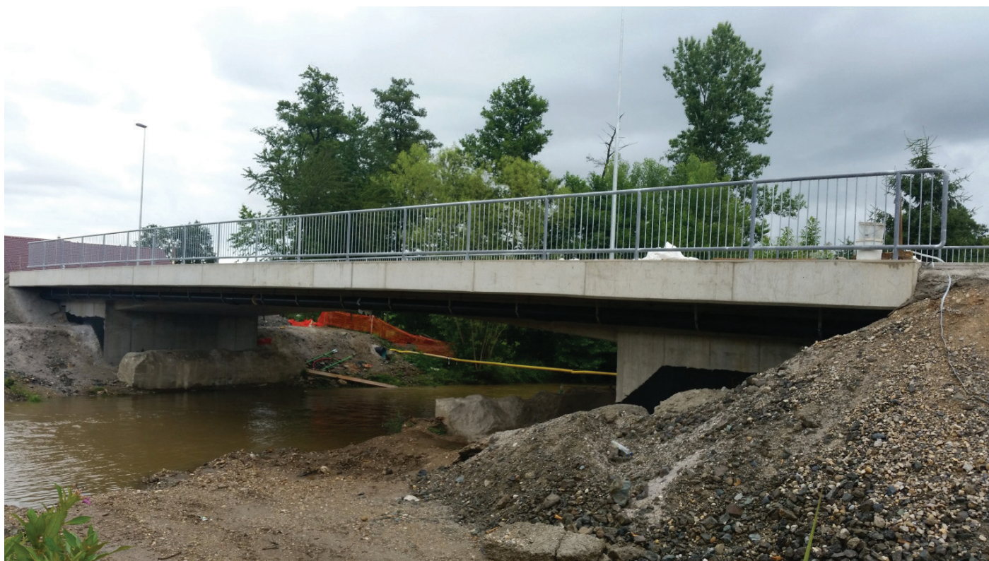
Slika 11 • Končna podoba mostu, na katerem smo opravljali meritve
