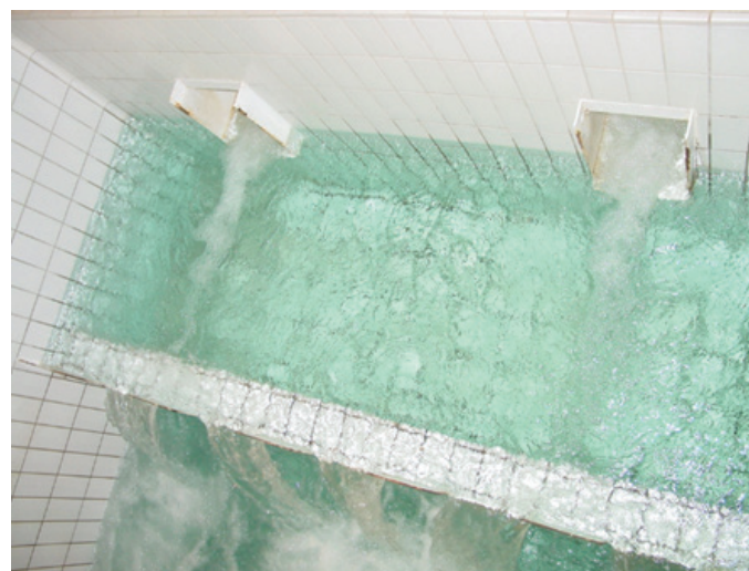
Slika 22 • Obrežni filtrat na iztoku iz lamelnih usedalnikov.
