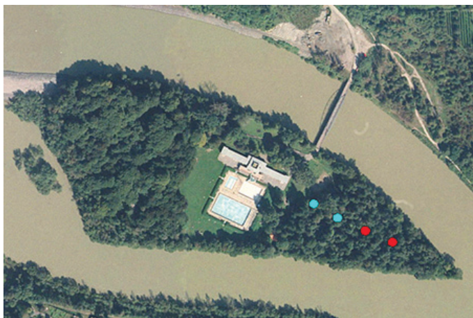
Slika 19 • Zgrajenemu vodnjaku na Mariborskem otoku za črpanje obrežnega filtrata so nasprotovali okoljevarstveniki.
