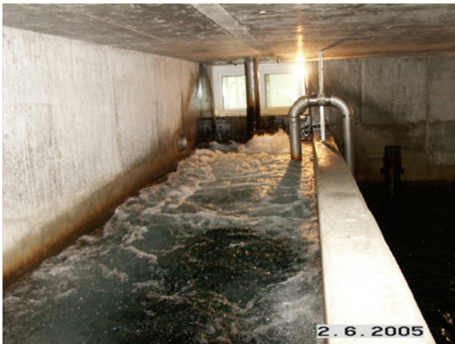
Slika 26 • Ozračevanje črpne podtalnice z injektorjem za načrtovano oksidacijo Fe in Mn v vodonosniku.
