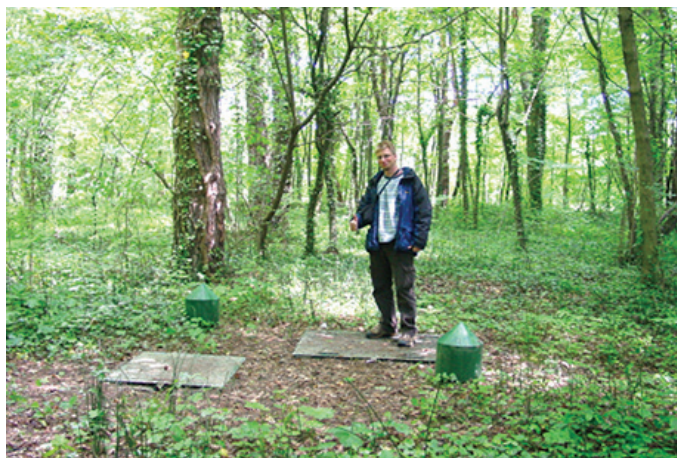
Slika 21 • Zakopani vodnjaki za zajem obrežnega filtrata na Mariborskem otoku.
