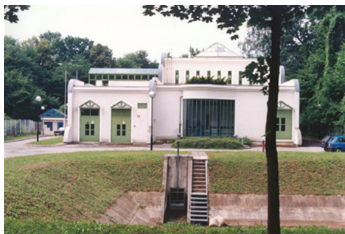
Slika 23 • Čistilna naprava za odstranitev peska, za eliminacijo Mn^{2+} in Fe^{2+} in ozračenje vode pred infiltracijo preko nalivalnih vodnjakov v podtalnico na vodarni Vrbanski plato.
