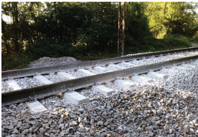
Slika 1 • Plavajoči pragovi na dveh odsekih železniške proge Divača-Koper.
