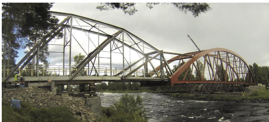
Slika 7 • Vzdolžno nameščanje nove konstrukcije, kjer stara konstrukcija predstavlja narivni kljun
