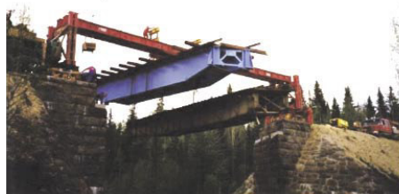
Slika 4 • Faze zamenjave stare in nove prekladne konstrukcije s pomočjo vrtenja le-teh okoli vertikalne osi za 90 stopinj
